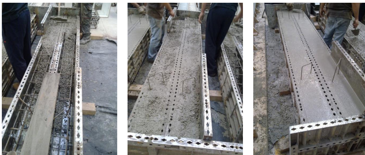
Figura 3.3 – Início da betonagem, antes e depois da vibração.
