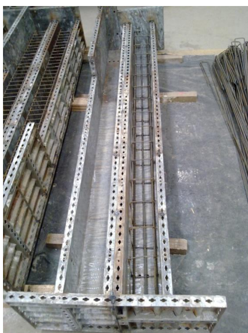
Figura.3.2 – Cofragens das vigas.
