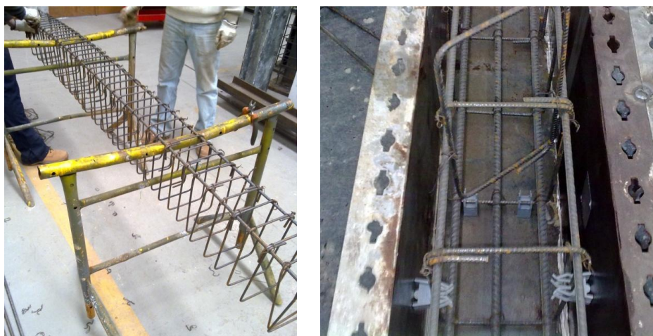
Figura 3.1 - Montagem das armaduras das vigas e espaçadores utilizados.
