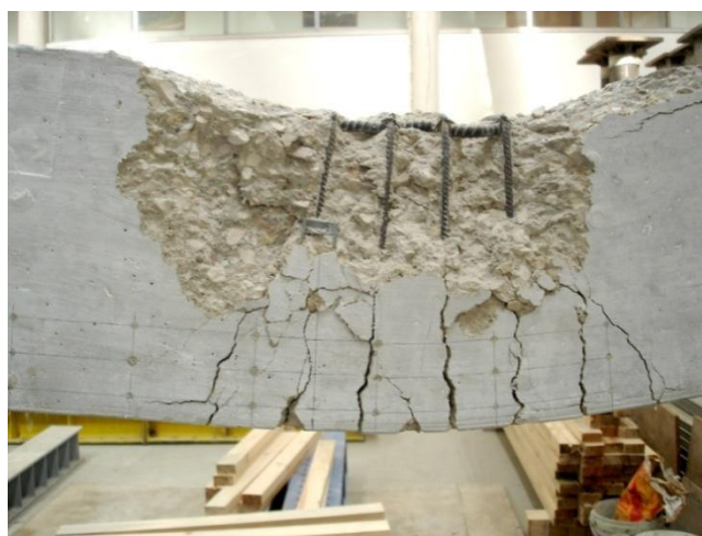
Figura 4.11 – Formação de fendas coincidente com a posição dos estribos na Viga2old.
