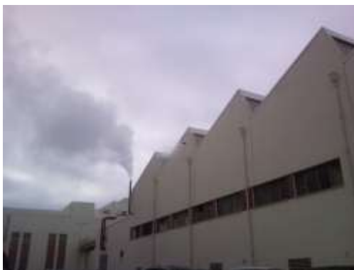
Figura 5.1 - Respiro do depósito atmosférico da central térmica dos HUC.
