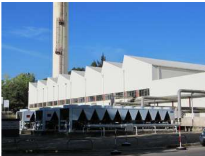
Figura 4.10 – Chillers de compressão – Carrier.
