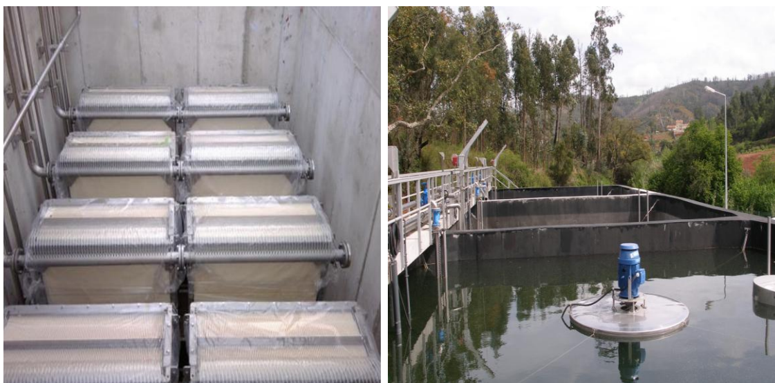
Figura 3.4 – a) Sistemas do tipo MBR e b) Sistema do tipo SBR
