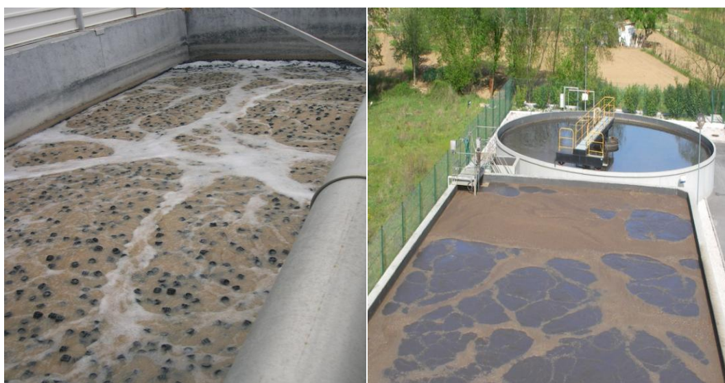
Figura 3.3 – a) Sistema do tipo MBBR e b) Sistema convencional de lamas ativadas
