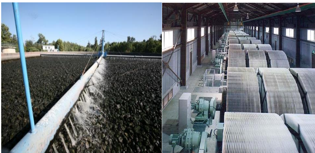
Figura 3.2 – a) Sistema do tipo leito percolador b) Sistema do tipo Biodiscos
