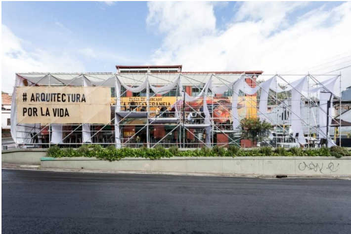
Figura 55. Instalación Activación Vertical , 2020, pelos Taller Architects, Colab-19 e SCA.
