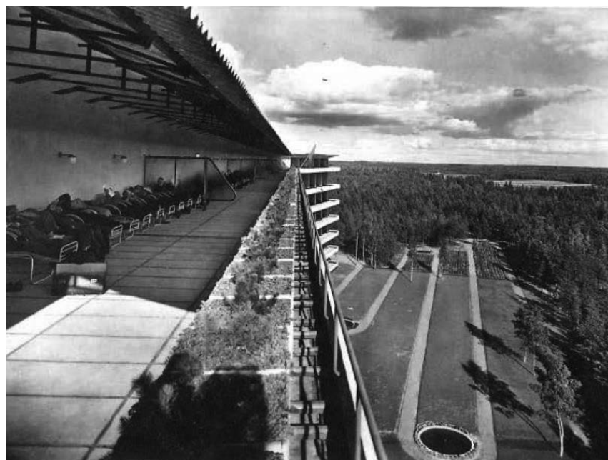
Figura 42. Paimio Sanatorium, na Finlândia, 1929-1933, por Alvar e Aino Aalto
