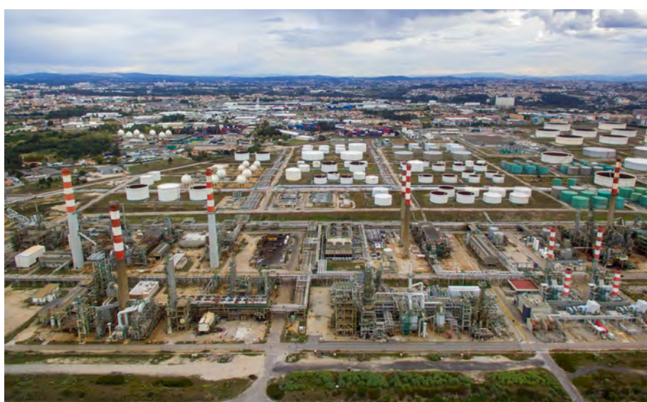
Fig.3: Vista aérea da Refinaria Petrolífera de Leça da Palmeira
