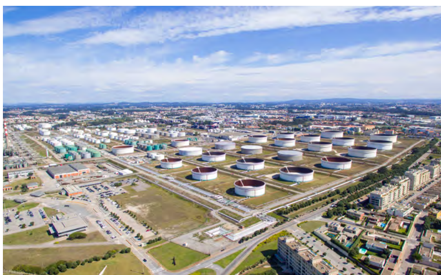
Fig.2: Vista aérea da Refinaria Petrolífera de Leça da Palmeira
