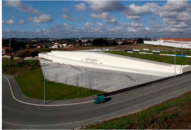
Fig.25: Vista Aérea do Estádio Custóias, Guilherme Machado Vaz
