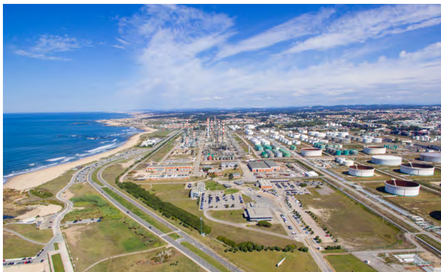
Fig.1: Vista aérea da Refinaria Petrolífera de Leça da Palmeira
