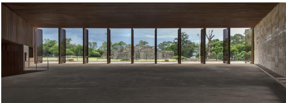
Figura 11 – Interior do centro cultural
