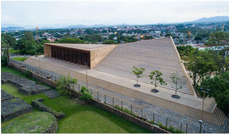
Figura 9 – Vista aérea do Centro Cultural Teopanzolco
