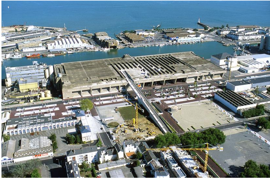
Figura 7 – Vista aérea da Base Submarina de Saint-Nazaire
