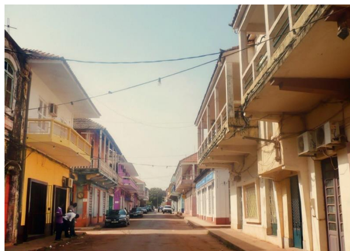
Figura 39 – Edifício da época colonial em Bissau Velho
