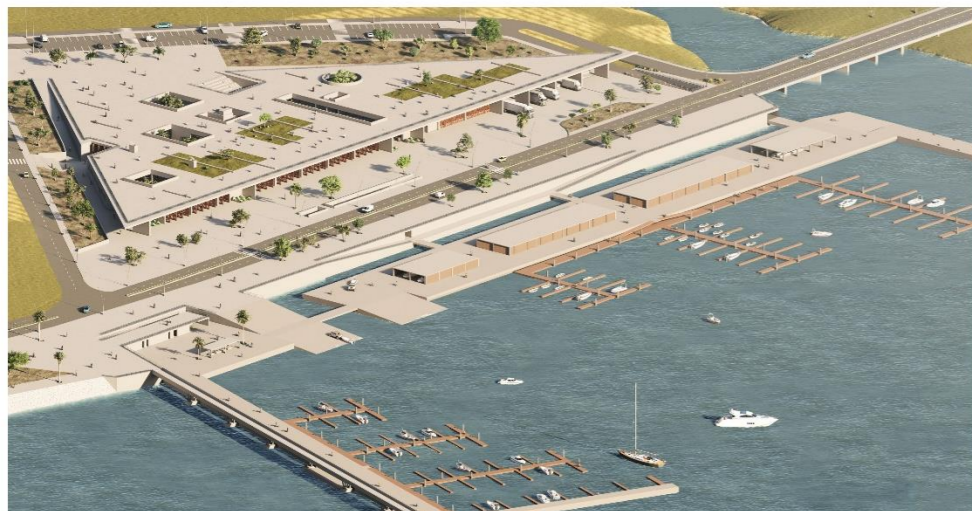
Vista aérea do conjunto
