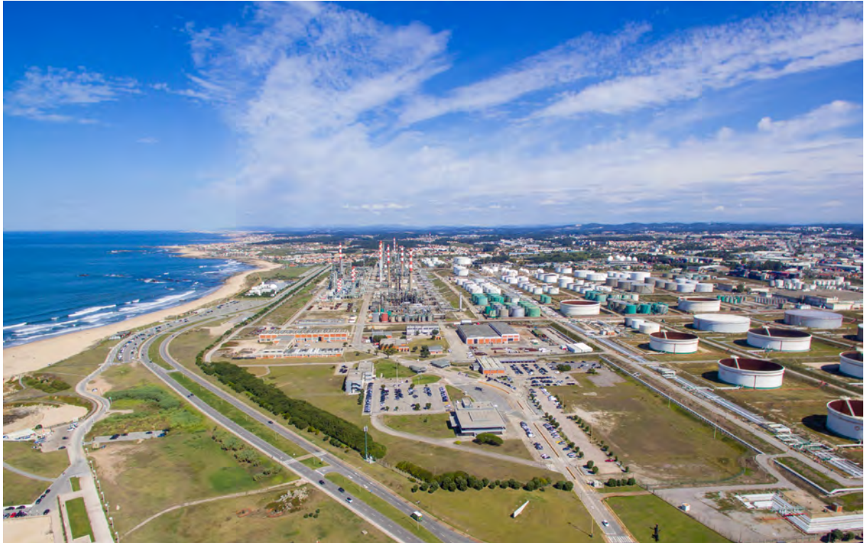
Fig. 3: Fotografia aérea da Refinaria de Leça da Palmeira
