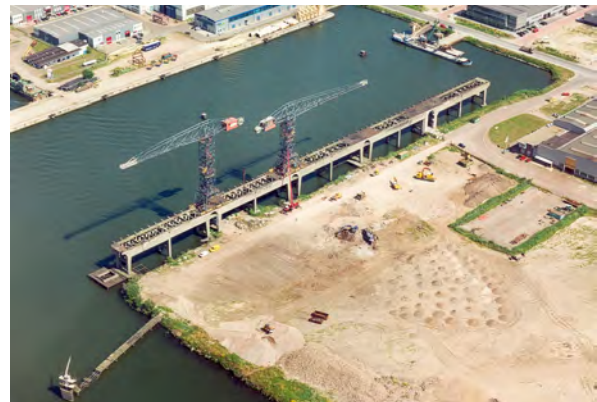
Fig. 20: Imagem aérea da estrutura existente
