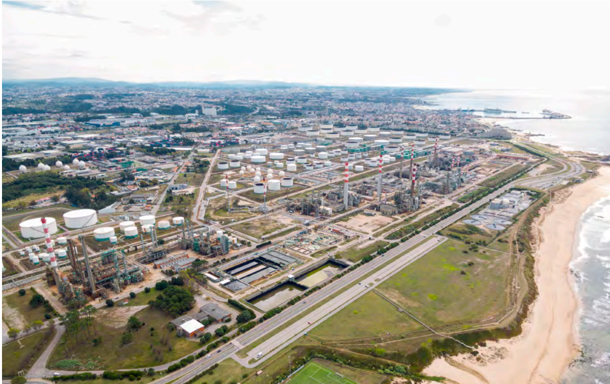
Fig. 1: Fotografia aérea da Refinaria de Leça da Palmeira
