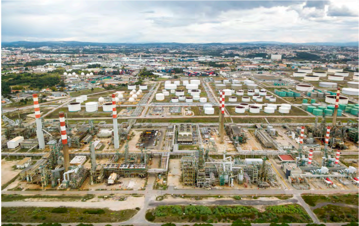
Fig. 5: Fotografia aérea da Refinaria de Leça da Palmeira
