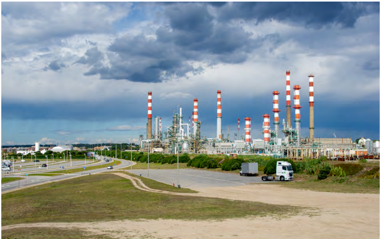
Fig. 4: Fotografia da Refinaria e Avenida Marginal
