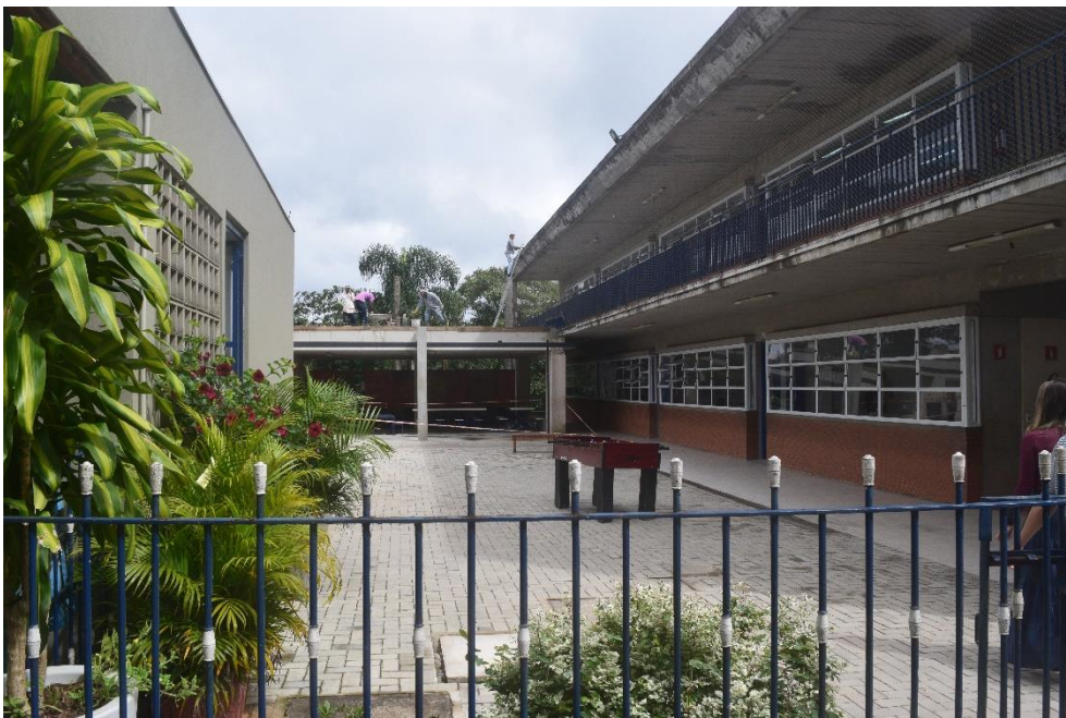
Fig. 4 – Lateral do prédio do ensino fundamental e refeitório ao fundo.
