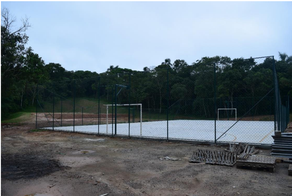
Fig. 18 – Quadra poliesportiva (em reforma).
