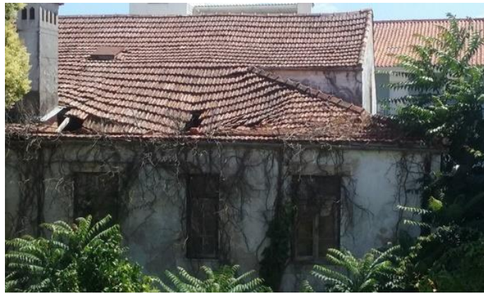
Figura 21 - Exemplo de critério 2 de estado de conservação
