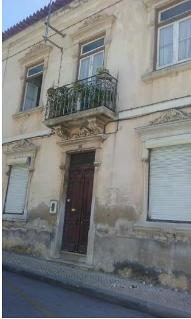
Figura 19 – Exemplo de critério 0.5 de estado de conservação
