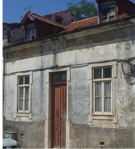
Figura 20 - Exemplo de critério 1 de estado de conservação
