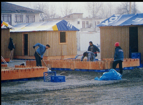
Fig.112 | Paper Log Houses em construção, Turquia.
