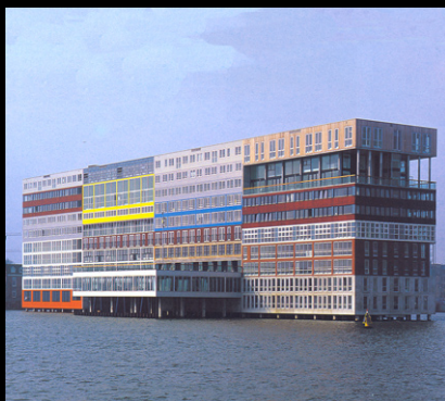
Fig.43 | Silodam , Amesterdão, MVRDV, 2001.
