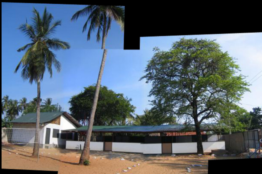
Fig.81-82 | Escola provisória , Ampara.
