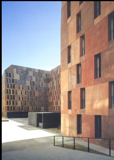
Fig.35-36 | Bloco de habitação Villaverde, 2005.
