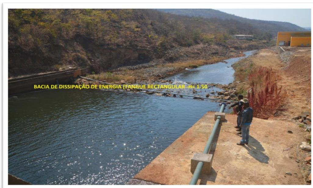
Figura 6.4 - Bacia de dissipação.(Fonte-própria 2015)
