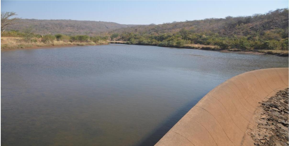
Figura 7.8 - Dique de derivação de águas para os dois canais de irrigação e canal de derivação da margem direita do rio.
