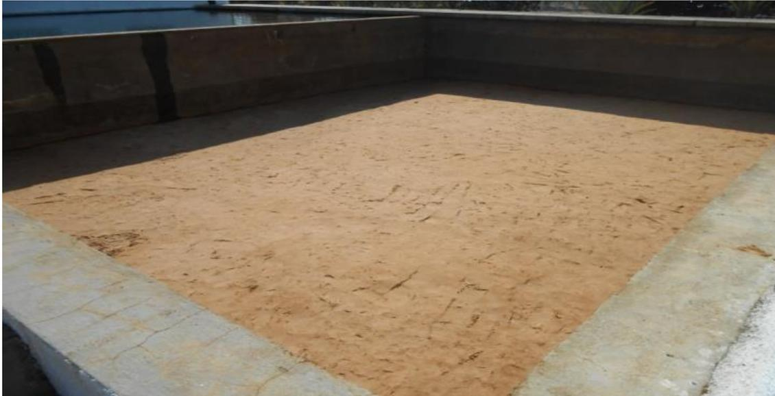
Figura 7.6 - Tanque de filtros lentos em manutenção (Fonte própria 2015).
