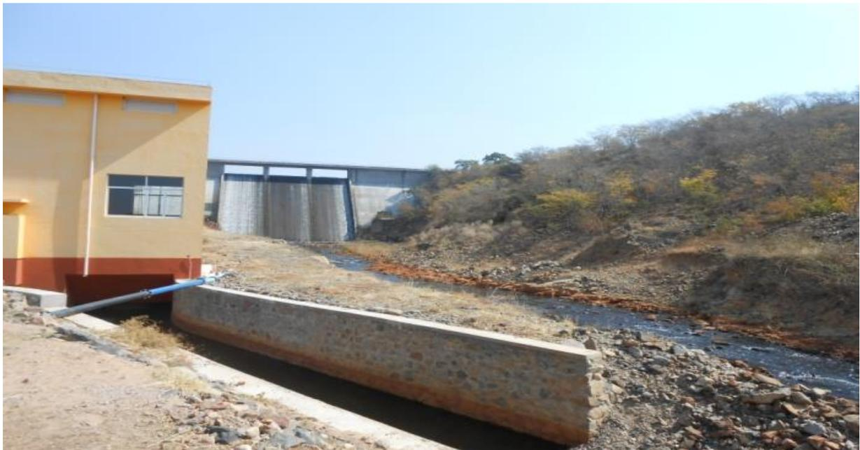
Figura 7.16 – Canal de restituição ao rio (Fonte própria 2015).
