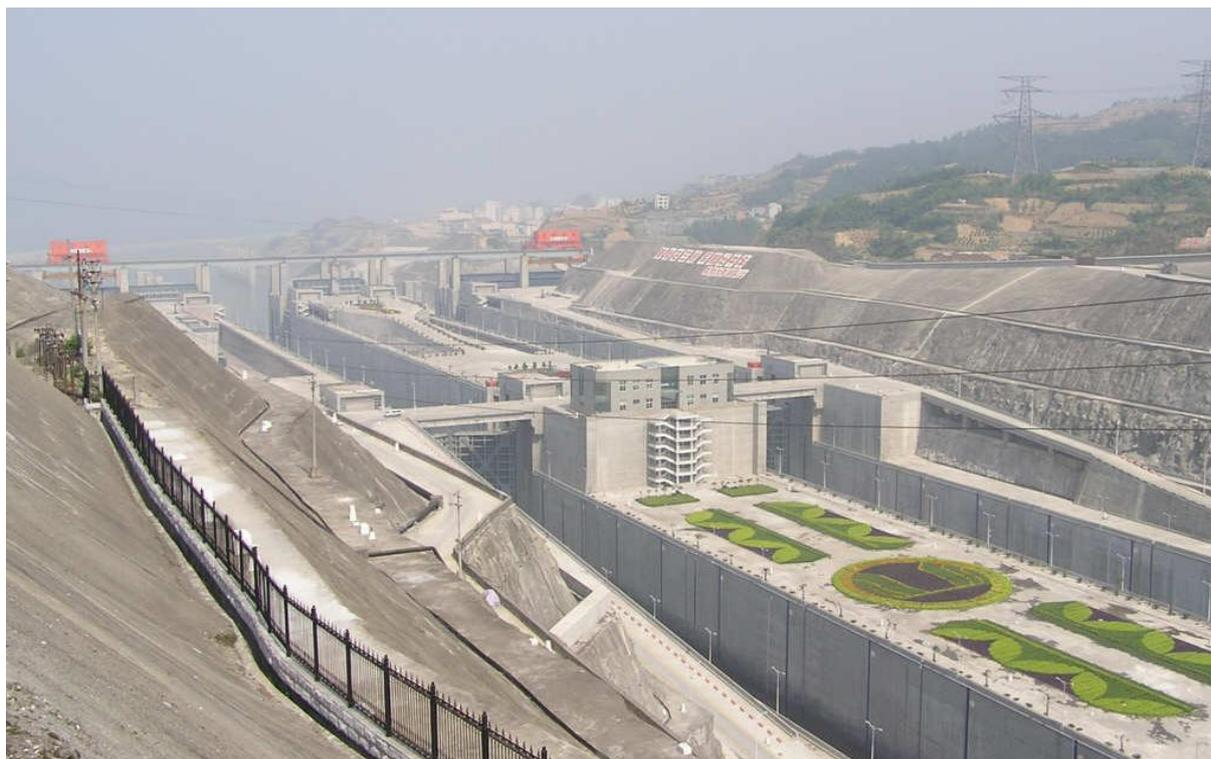
Figura 4.2 – Eclusas na barragem das Três Gargantas.
