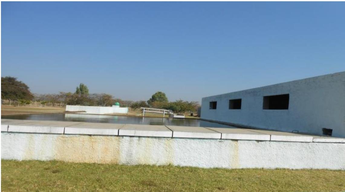
Figura 7.5 - Tanque de filtro lento em funcionamento (Fonte própria 2015).
