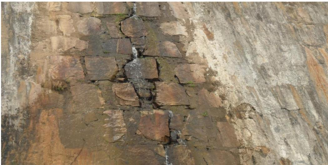
Figura 4.16 – Fissura na barragem das Neves- (Huila 2015).
