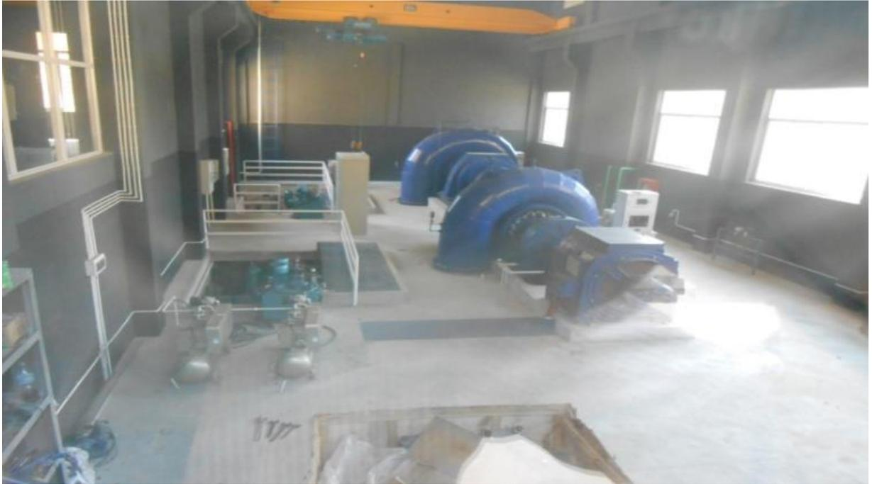
Figura 7.15 – Turbinas francis de eixo horizontal (Fonte própria 2015).
