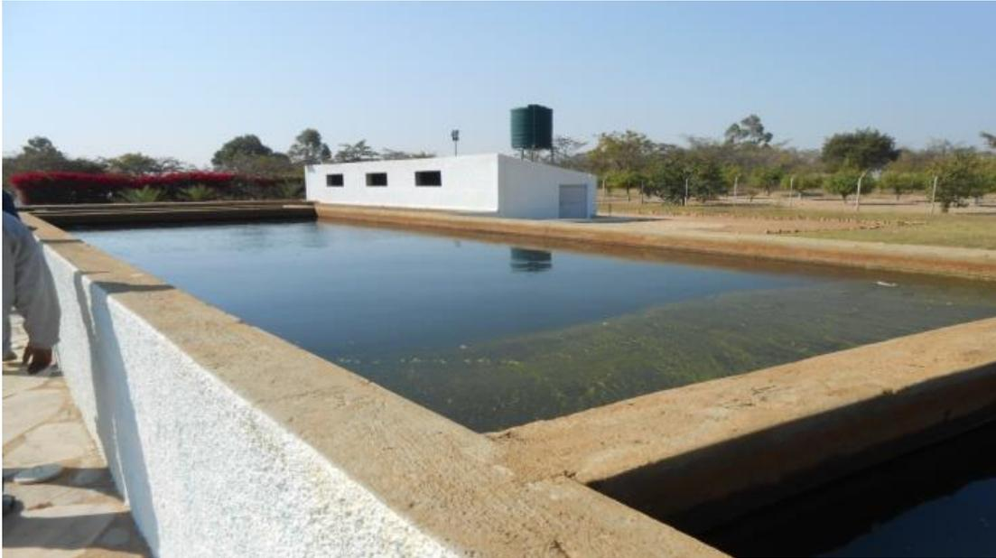
Figura 7.4 - Tanques de floculação e decantação (Fonte própria 2015).
