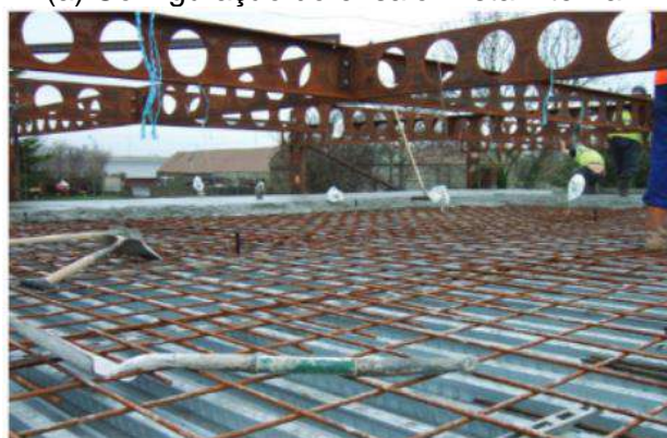
(c) Vista superior da laje antes da concretagem
