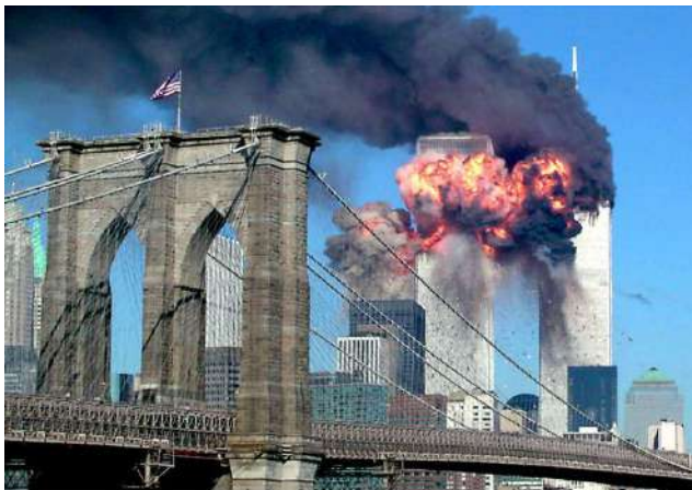
(a) Colapso devido a falha do sistema estrutural misto: o caso do World Trade Center
