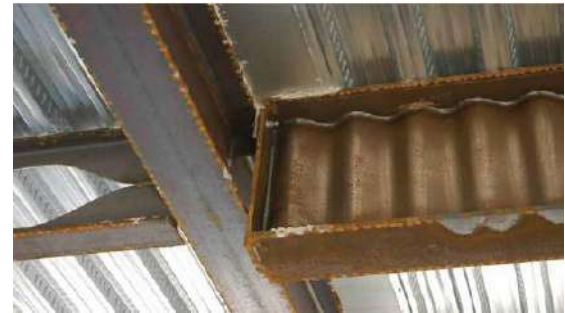
(b) Vigas convencionais, alveolares e de alma senoidal
