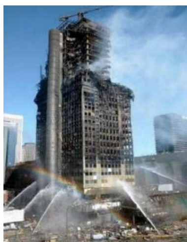
(a) Windsor Tower, em Madri, Espanha
