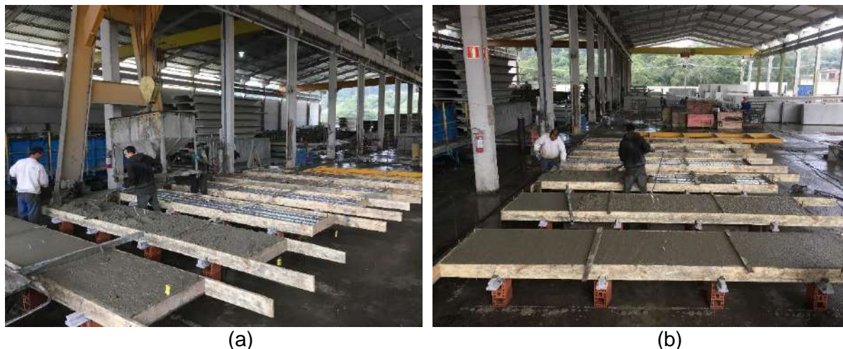
Figura 45 – Vista do (a) lançamento e (b) vibração do concreto das LA
