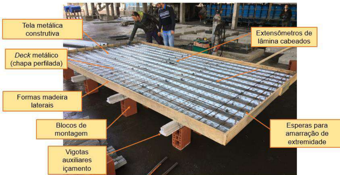
Figura 47 – Vista geral da execução do projeto das LF
