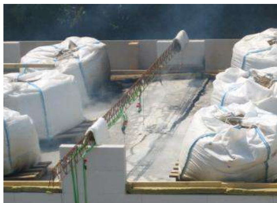
Figura 32 – Fissura em laje mista contínua: ensaio em Munique, Alemanha Fonte: Stadler (2012)
