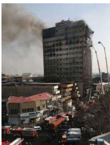
(b) Plasco Building, em Teerã, Irã
