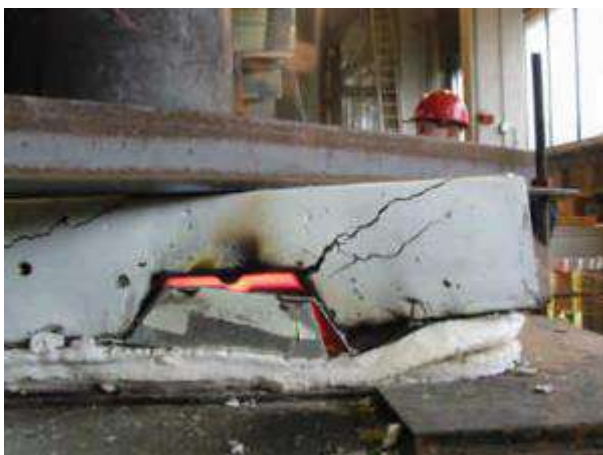
(a) Desprendimento chapa perfilada do concreto do estudo de Lim e Wade (2002)
