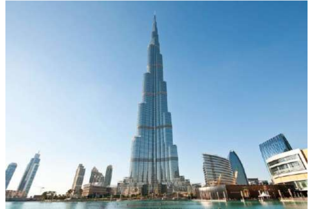
(d) Burj Khalifa, em Dubai, Emirados Árabes Unidos, com altura de 828m
