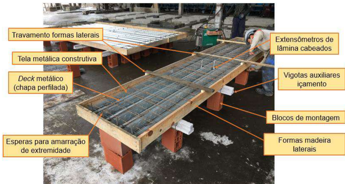
Figura 44 – Vista geral da execução do projeto das LA
