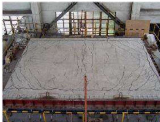
(d) Configuração fissuras no caso das lajes com cobrimento das armaduras de 30 mm
