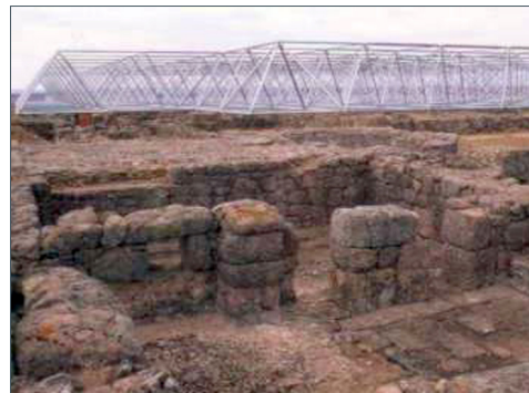
[Fig. 06] Vista parcial das estruturas novas e das ruínas.
