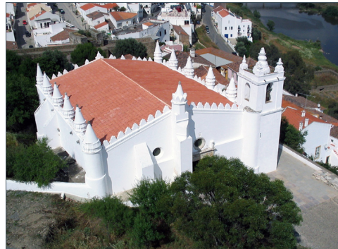
[Fig. 06] Vista da Igreja Matriz de Mértola - antiga mesquita.
