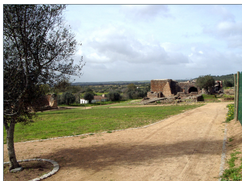
[Fig. 06] Vista do percurso exterior do recinto das ruínas de São Cucufate.
