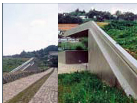
[Fig. 08] Vista da cobertura e da lateral do edifício do CA de Alcalar.
