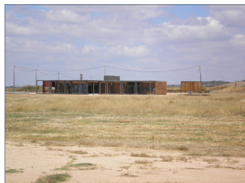
[Fig. 08] Vista do CAI da villa romana de Torre de Palma.
