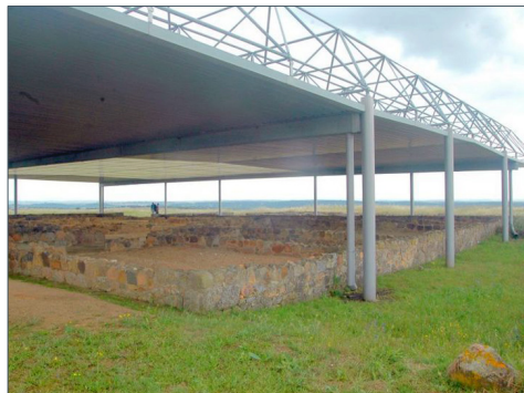
[Fig. 05] Pormenor da cobertura nova das ruínas da domus de Torre de Palma.
