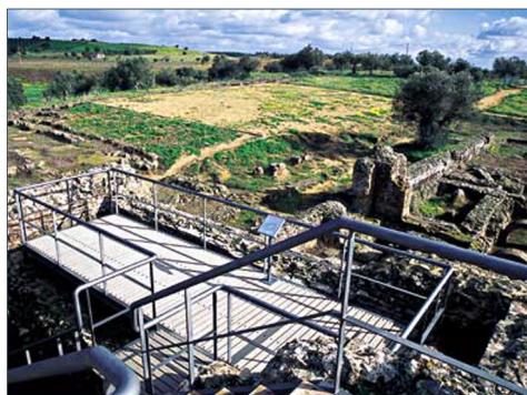
[Fig. 04] Percurso nas ruínas do Convento de São Cucufate.
