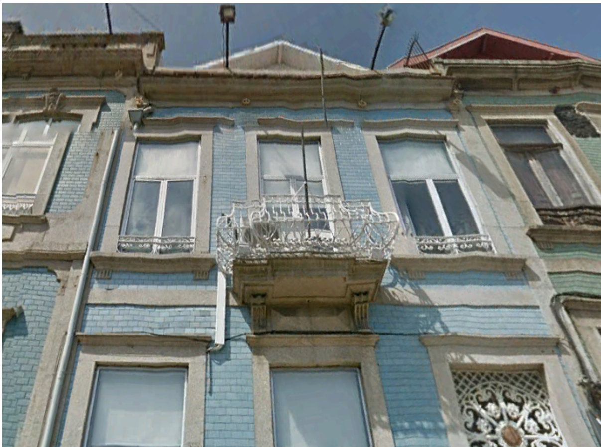
Figura 1- Fachada do Edifício
