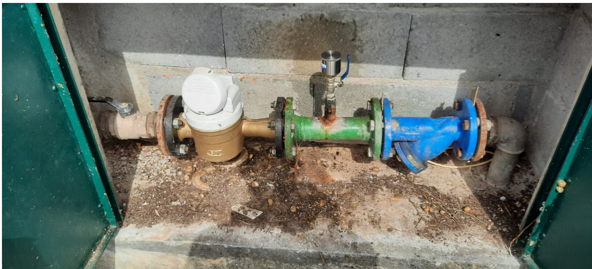
Figura 3.8 – Instalação do sensor no totalizador pelas Águas de Coimbra.
