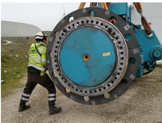
Figura 4 Substituição do rolamento principal
