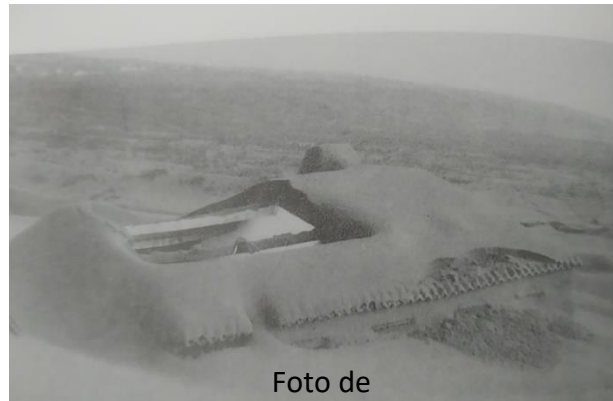
Figura 24 - Cobertura e desabamento de um telhado pelo peso das cinzas, ocorrida durante uma fase eruptiva do vulcão dos Capelinhos, na ilha do Faial, nos Açores (segundo Forjaz, 2007).
