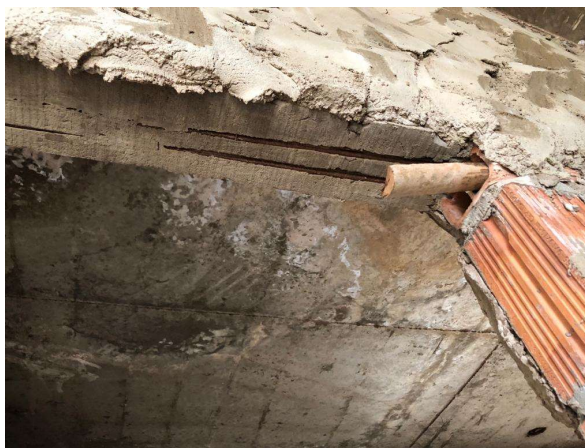
Figura (5.8) - Armaduras Expostas. Arquivo pessoal (2020).
