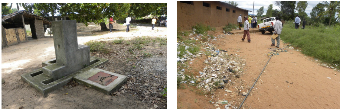
Figura 19. Abastecimento de Água (Fontenário Público e Ligação domiciliar à superfície) Fonte: (Autora)
