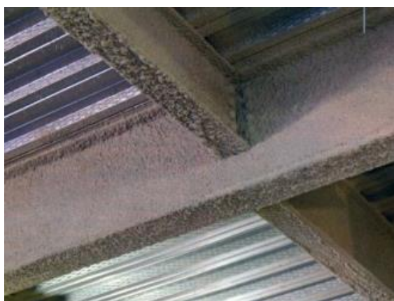
Figura 2-19 – Proteção com materiais projetados
