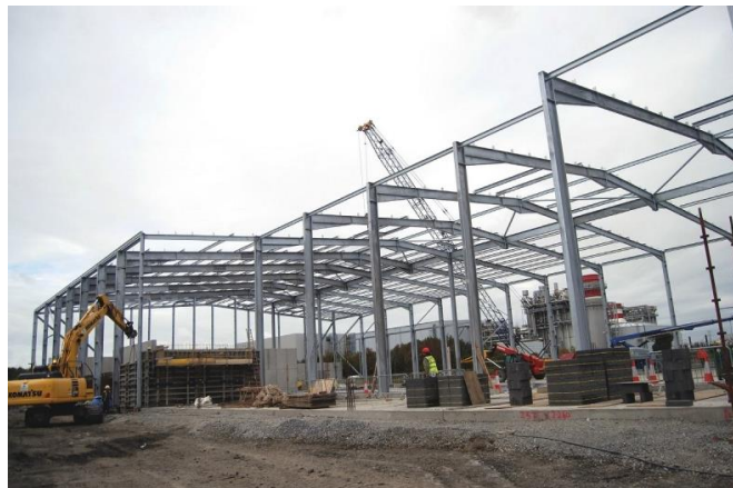
Figura 2-2 – Edifício metálico porticado
