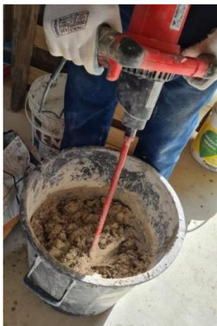
Figura 3.1 - Obtenção da amassadura com recurso a misturadora elétrica.
