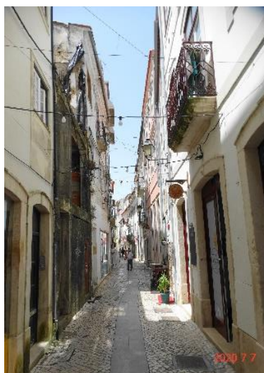
Conjunto urbano degradado
