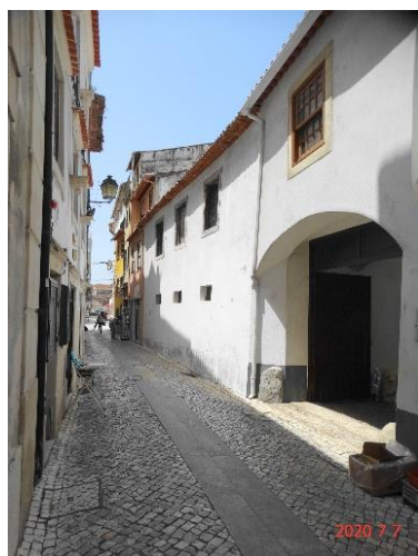
Edifício descaracterizado e reforçado com betão armado
