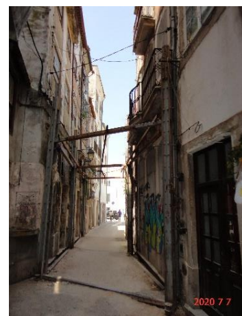
Conjunto urbano degradado
