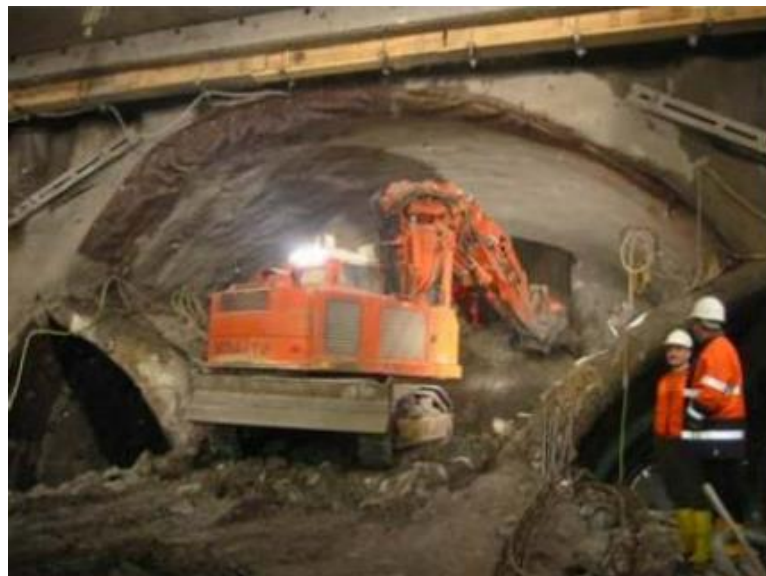
Figura 2.4 – Escavação sequencial feita por máquinas de ataque pontual utilizando o NATM (Almeida e Sousa, 2020).
