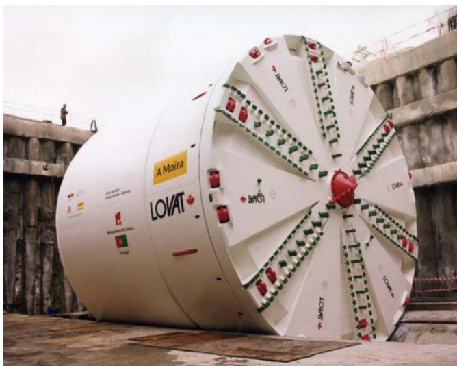
Figura 2.5 – Tuneladora usada na escavação do troço Campo Grande – Odivelas (linha Amarela) (Salgueiro Amaral, 2006).
