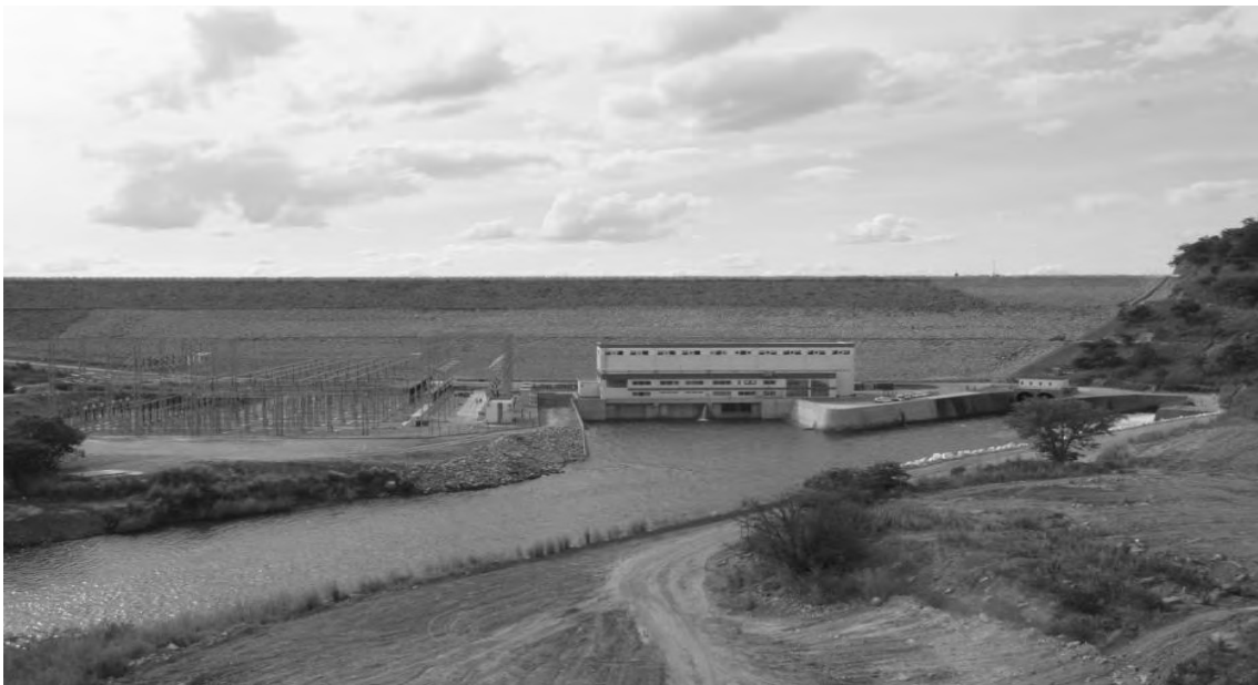
Figura 5.7 - Barragem do Gove (COBA, 2011).
