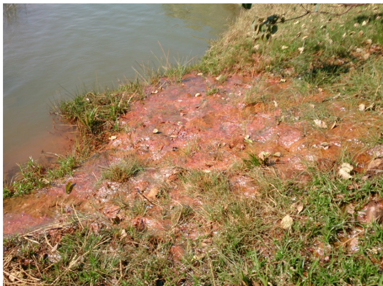
Figura 5.7 - Colóides de ferro observados na margem esquerda da barragem.
