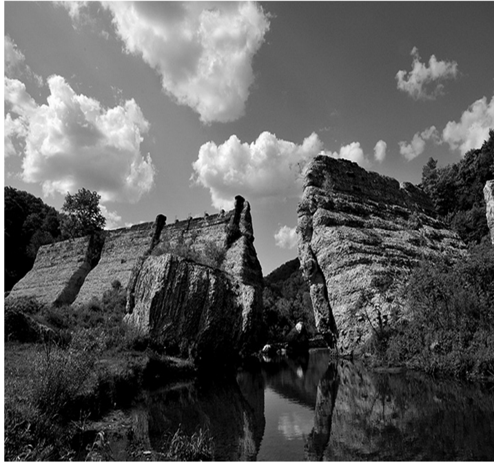
Figura 2.5 - Rotura da barragem de Austin.
