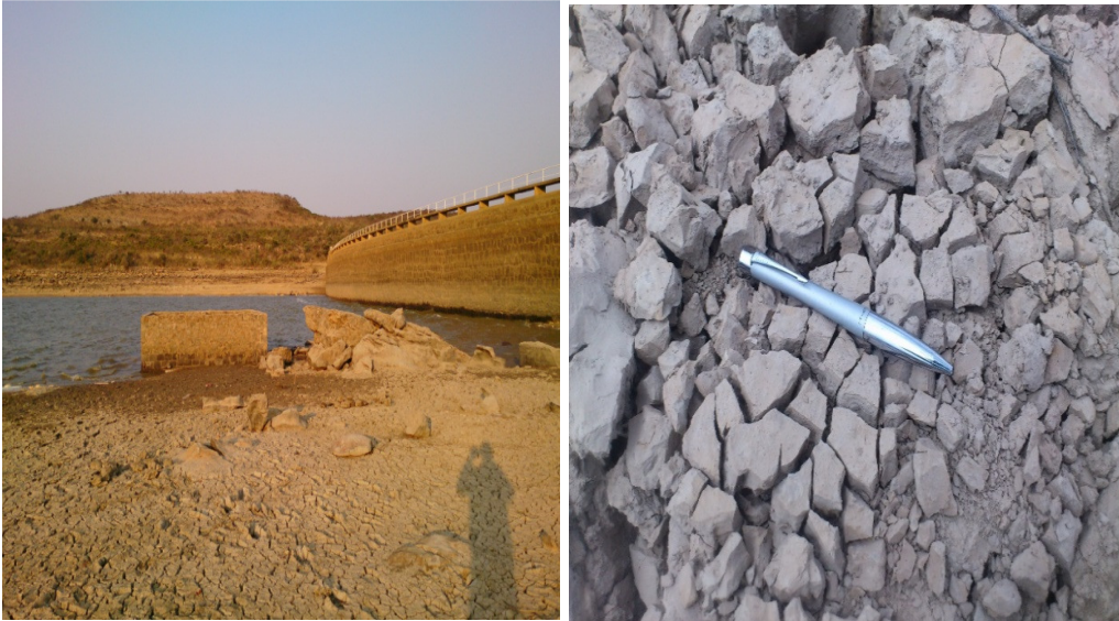
Figura 4.6 - Fendas de dissecção observadas nos terrenos da albufeira da barragem das Neves.
