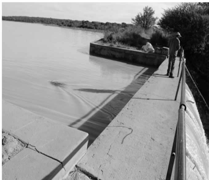
Figura 3.17 - Vista parcial do corpo da barragem em descargas de água.
