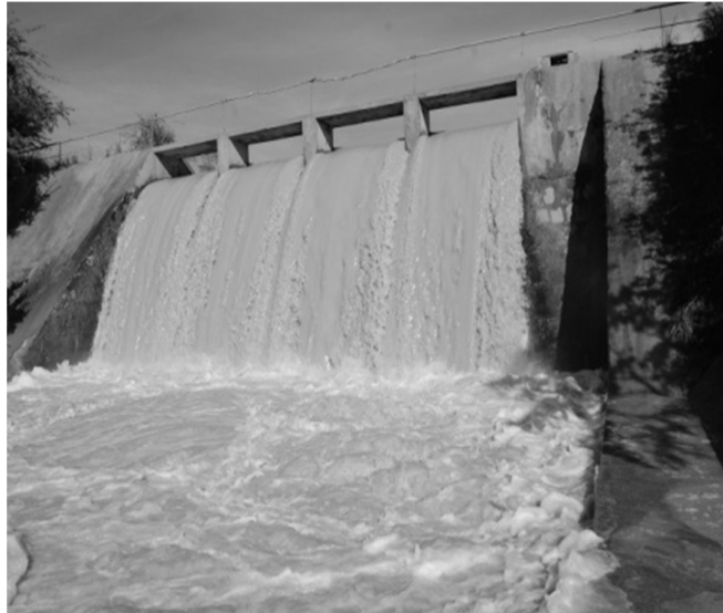
Figura 3.16 - Vista parcial do corpo da barragem em descargas de água.
