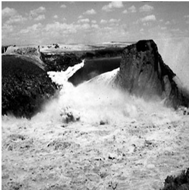
Figura 1.2 - Rotura da barragem de Teton.
