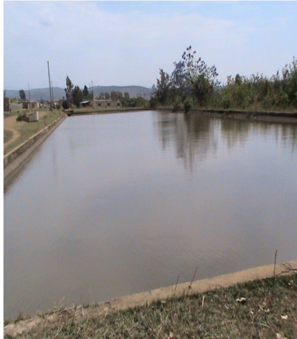
Figura 3.6 - Primeiro reservatório com a capacidade de 9000 m 3 (Yoso Luis, Humpata, 2013).
