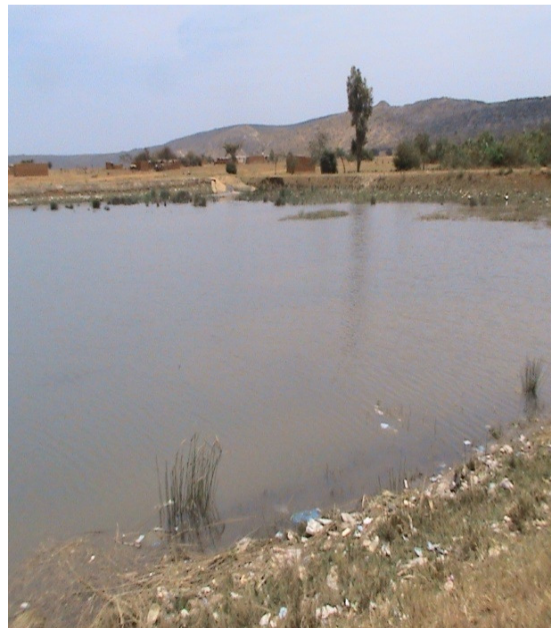
Figura 3.7 - Segundo reservatório com a capacidade de 30000 m 3 (Yoso Luis, Humpata, 2013).
