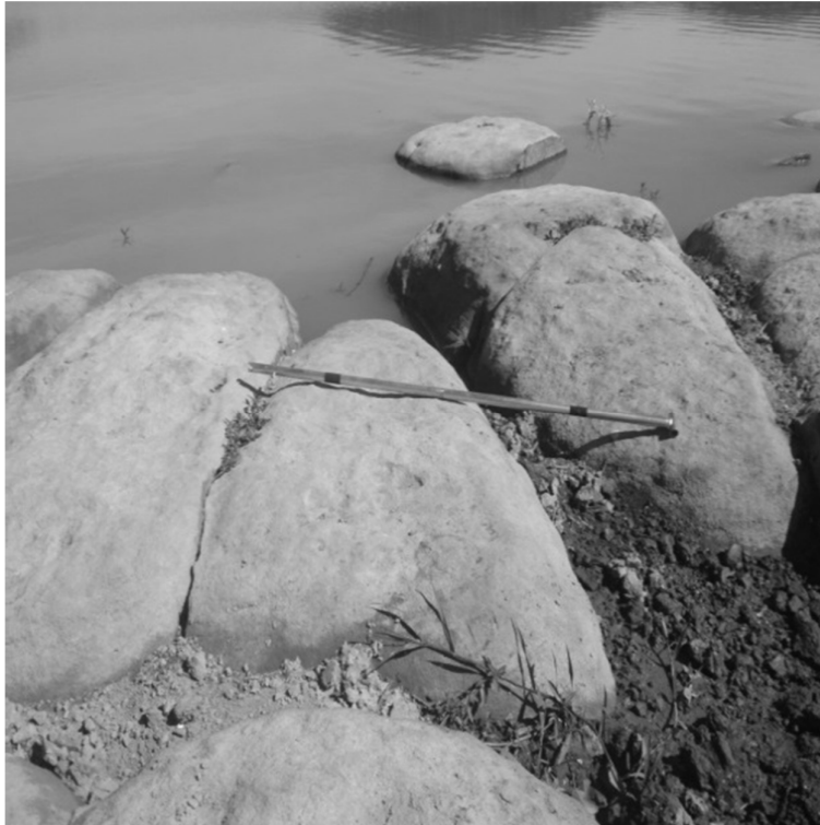
Figura 4.4 - Alteração das rochas na albufeira da barragem das Neves.
