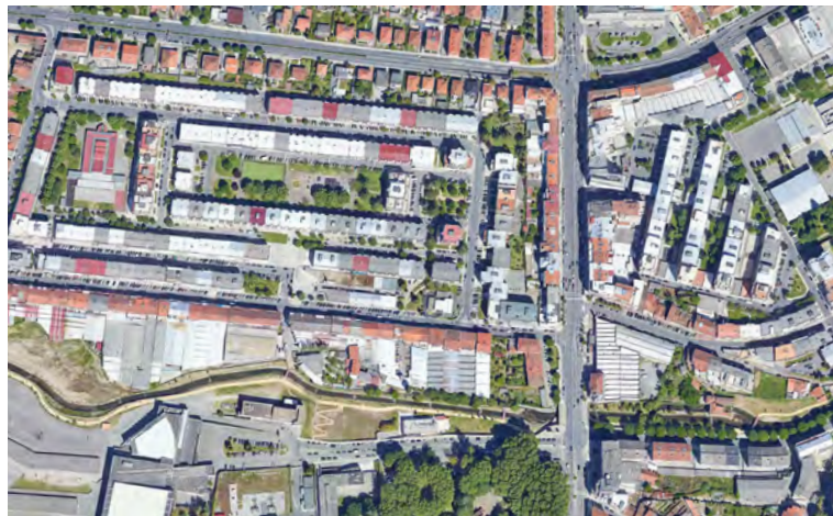
Fig.135 - Vista aérea da reurbanização do Fujacal, do Carandá e do Lugar das Lages
