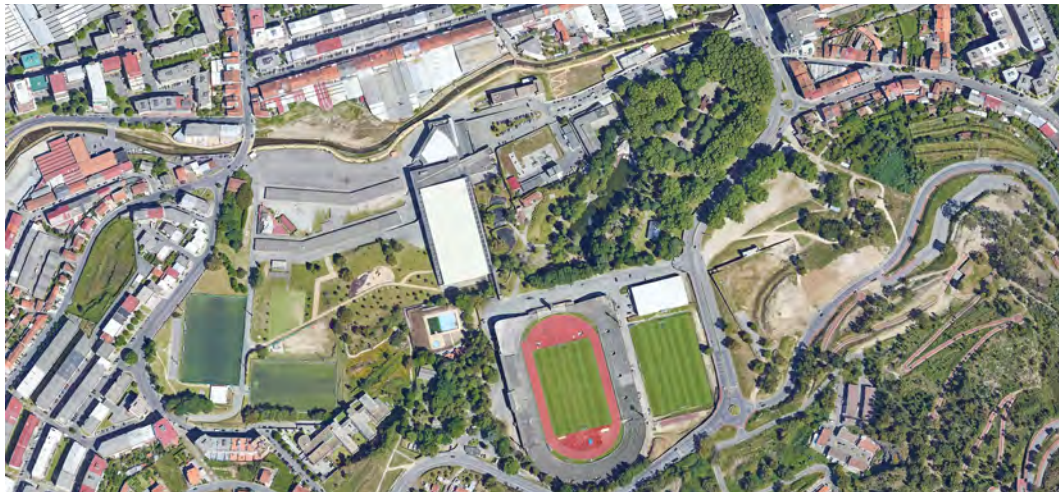
Fig. 39 - Vista aérea do Parque da Ponte e do Estádio
