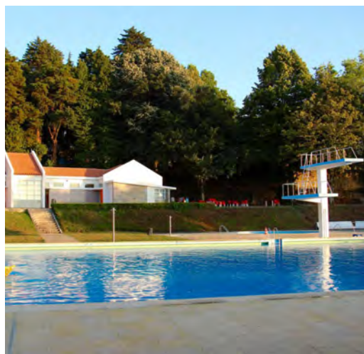
Fig. 34 - Piscina Municipal (após obras de requalificação)
