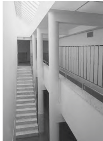
Fig.102 - Espaço interior do edifício
