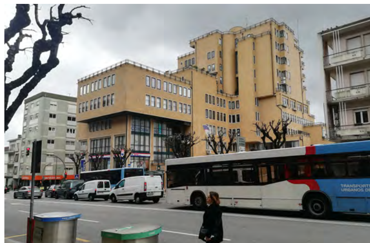
Fig. 119 - Centro Comercial Granjinhos
