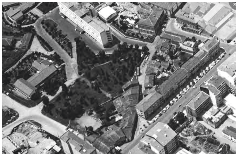
Fig. 93 - Rua dos Granjinhos antes da demolição
