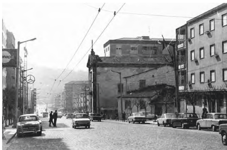
Fig. 94 - Antiga Igreja de São Lázaro na AL
