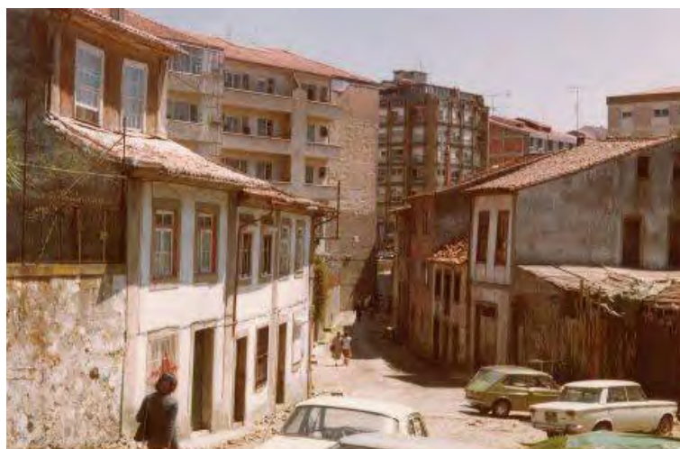
Fig. 95 - Rua dos Granjinhos
