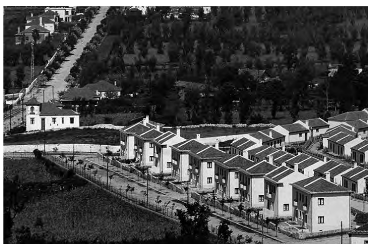
Fig. 55 - Bairro das Casas Económicas de Braga (1939)
