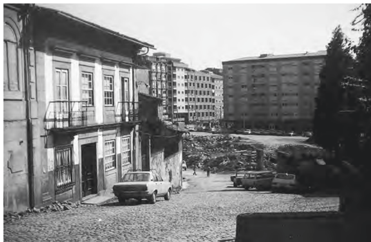
Fig. 96 - Processo de demolição da rua dos Granjinhos
