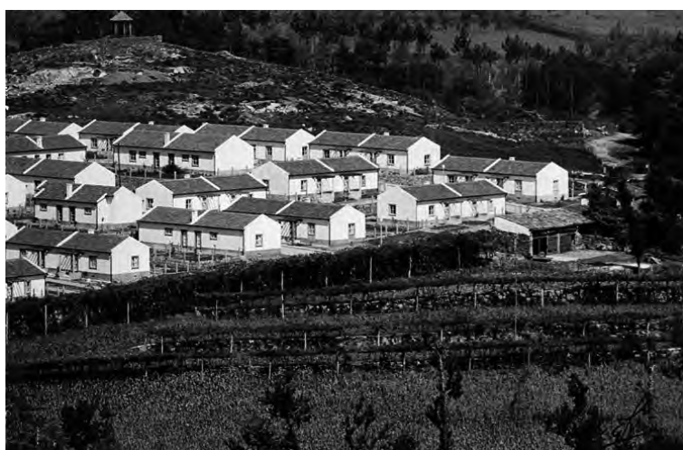
Fig. 54 - Bairro das Casas Económicas de Braga (1939)
