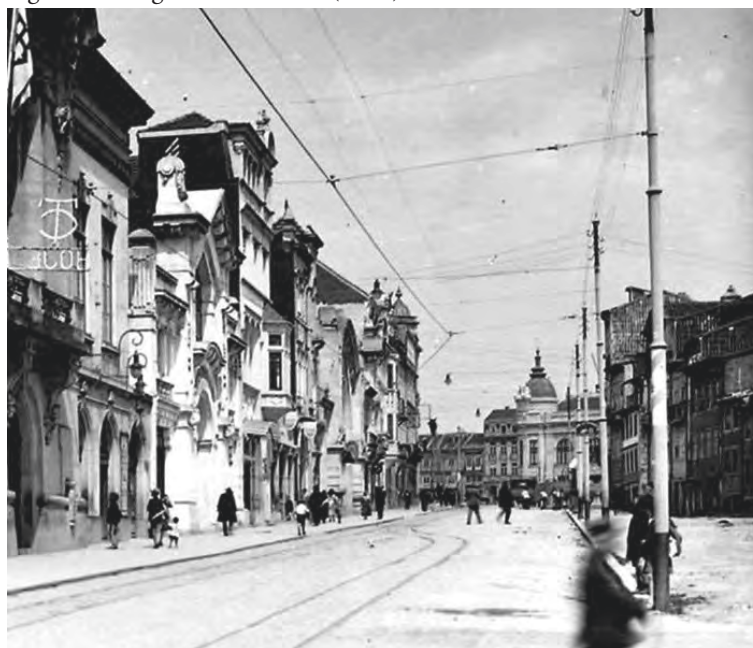
Fig. 16 - Troço da AL correspondente à 1º fase da sua construção
