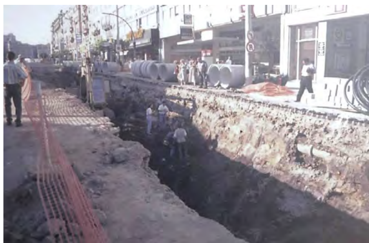
Fig. 113 - Vestígios arqueológicos (construção do prolongamento do túnel)
