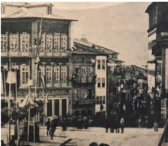
Fig. 12 - Cruzamento entre o Campo de Sant'Anna e a Rua das Águas
