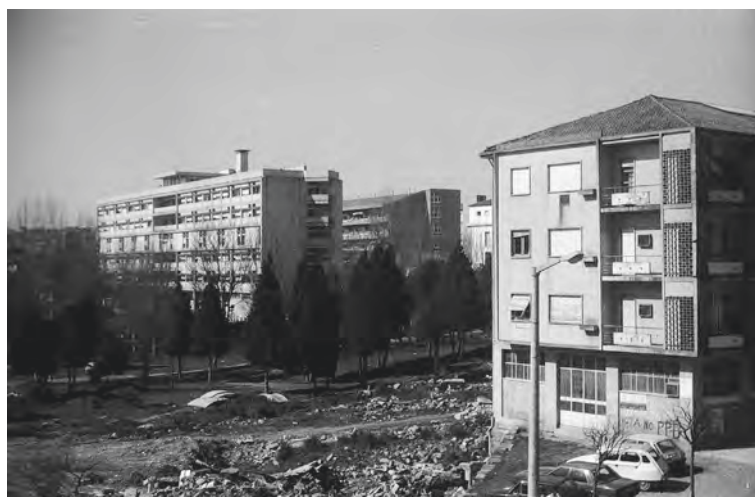
Fig. 97 - Rua dos Granjinhos após a demolição
