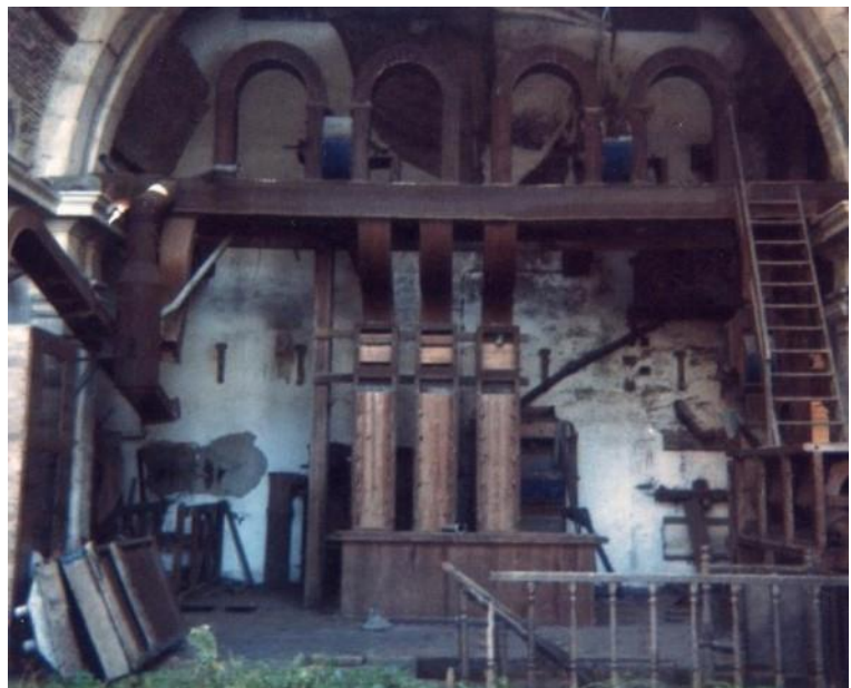
Imagem 3, Estruturas industriais inseridas na igreja
