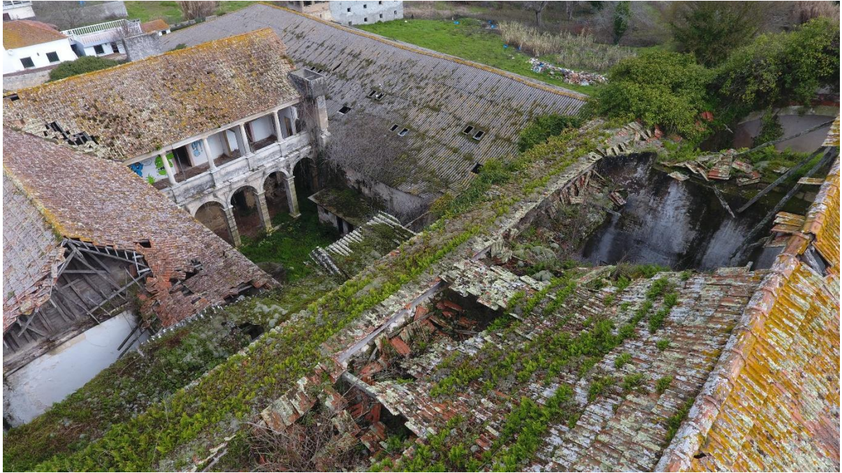
Imagem 16, claustro original, barracão industrial e telhado da igreja
