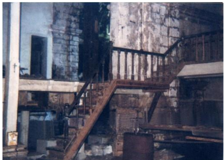
Imagem 4, Estruturas industriais inseridas na igreja
