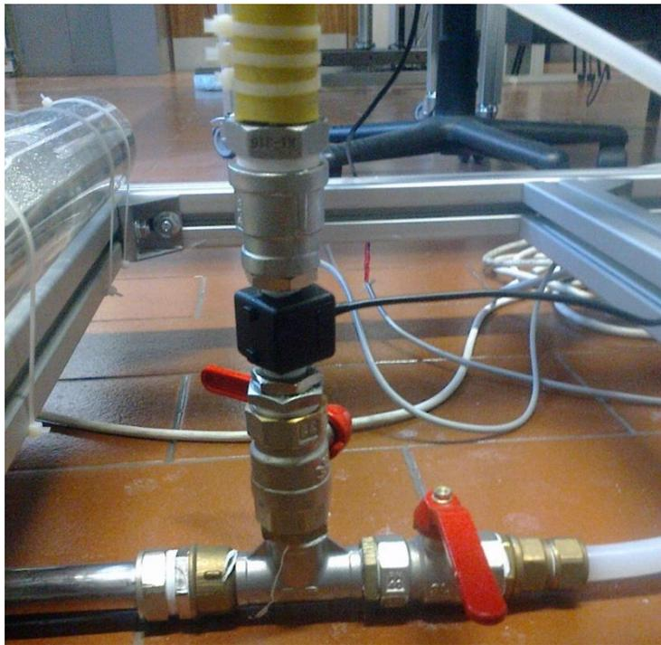
Figura 54 - Alimentação de água do conjunto 1b (válvulas de esfera com manípulo vermelho)
