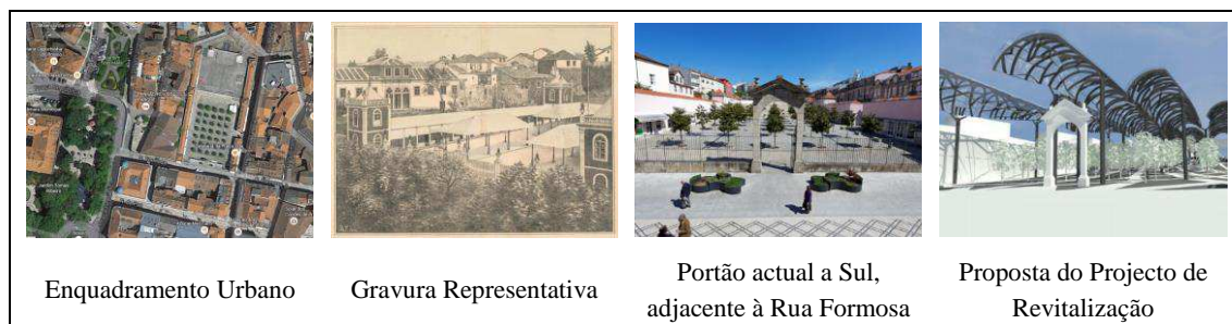
Figura 3.2 – Perspetiva de enquadramento e evolução temporal do Mercado 2 de Maio (adaptado de Viseu Novo, SRU, 2015)
