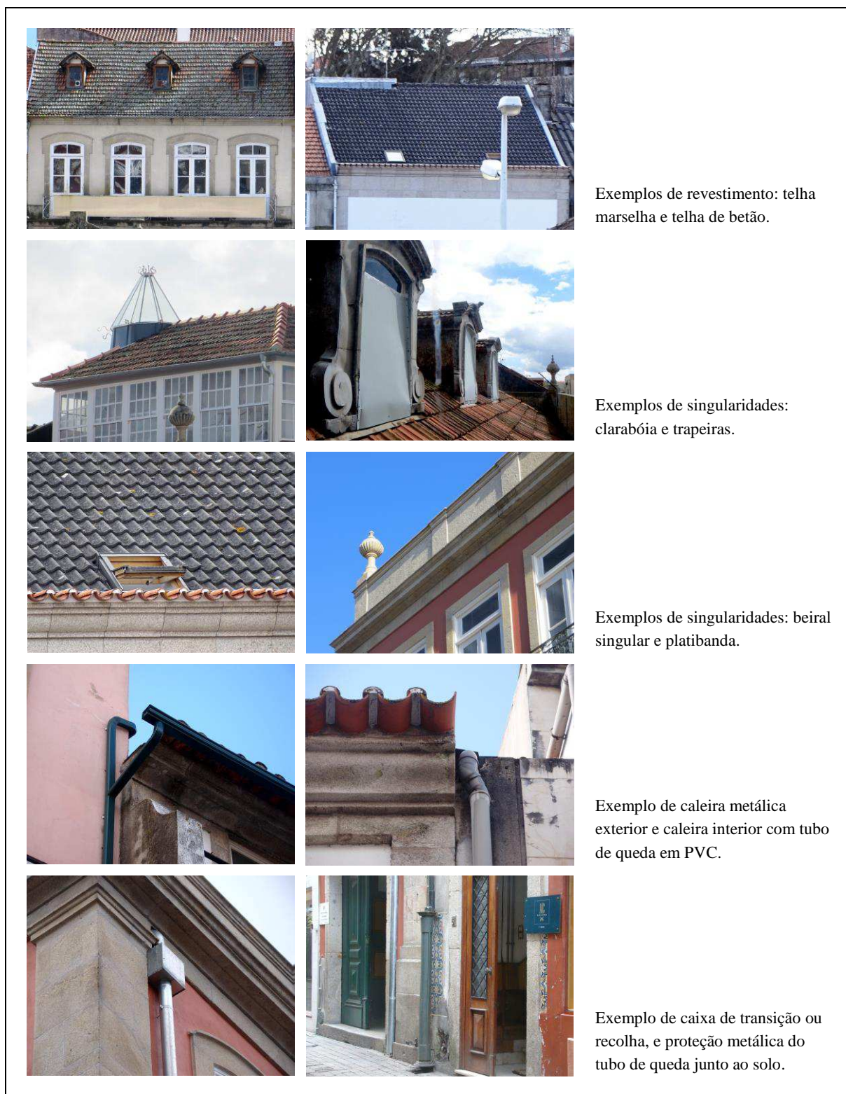
Figura 3.9 – Exemplos ilustrativos de revestimentos, singularidades e sistemas de drenagem nas coberturas observadas
