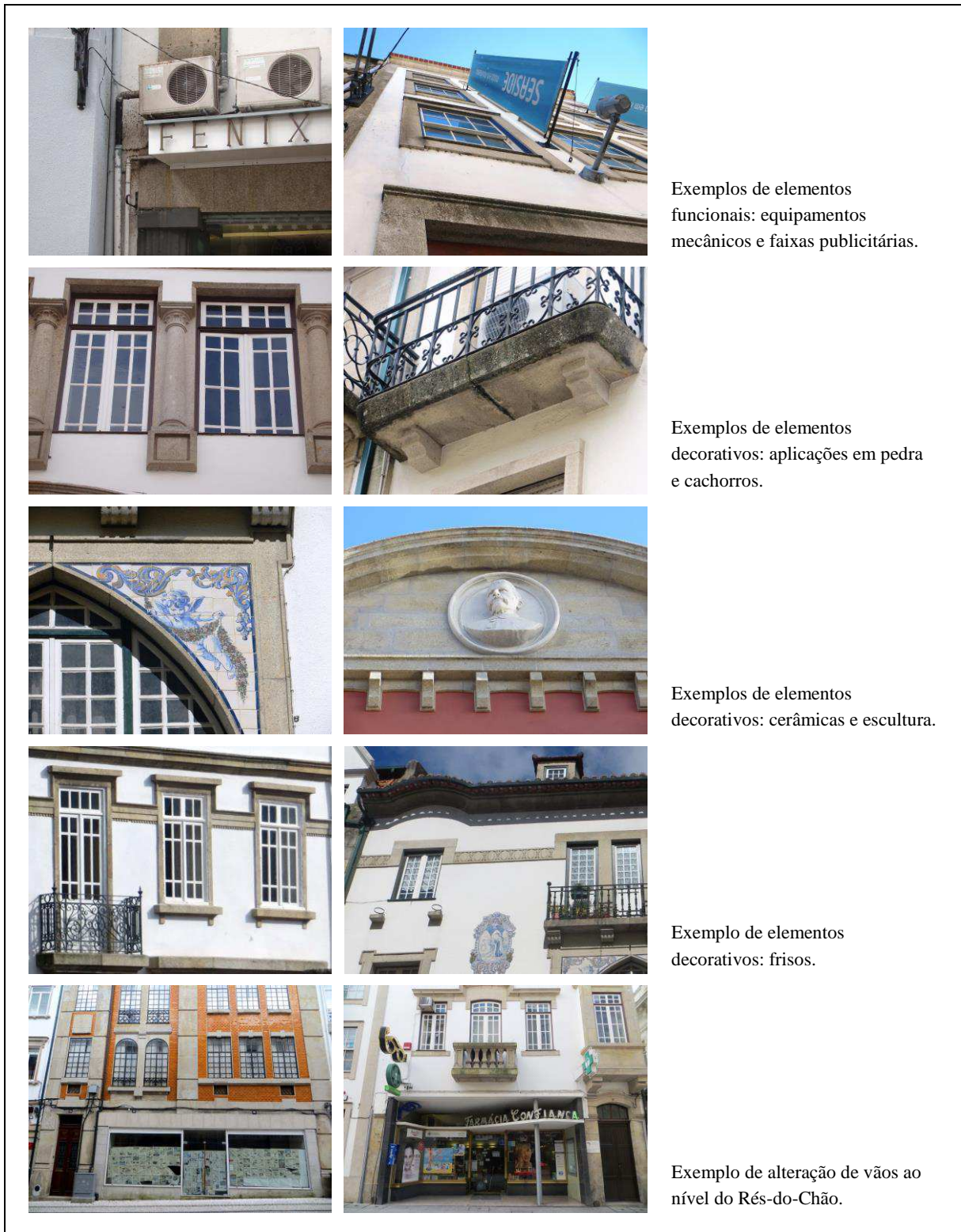
Figura 3.14 – Exemplos ilustrativos de elementos funcionais, elementos decorativos e alterações no rés-do-chão em paredes de fachada
