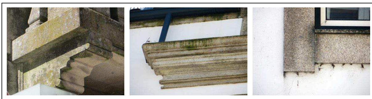
Figura 4.3 – Exemplos de ataque biológico em cachorro (1), escorrências em aplicação decorativa de pedra (2) e manchas em moldura (3)
