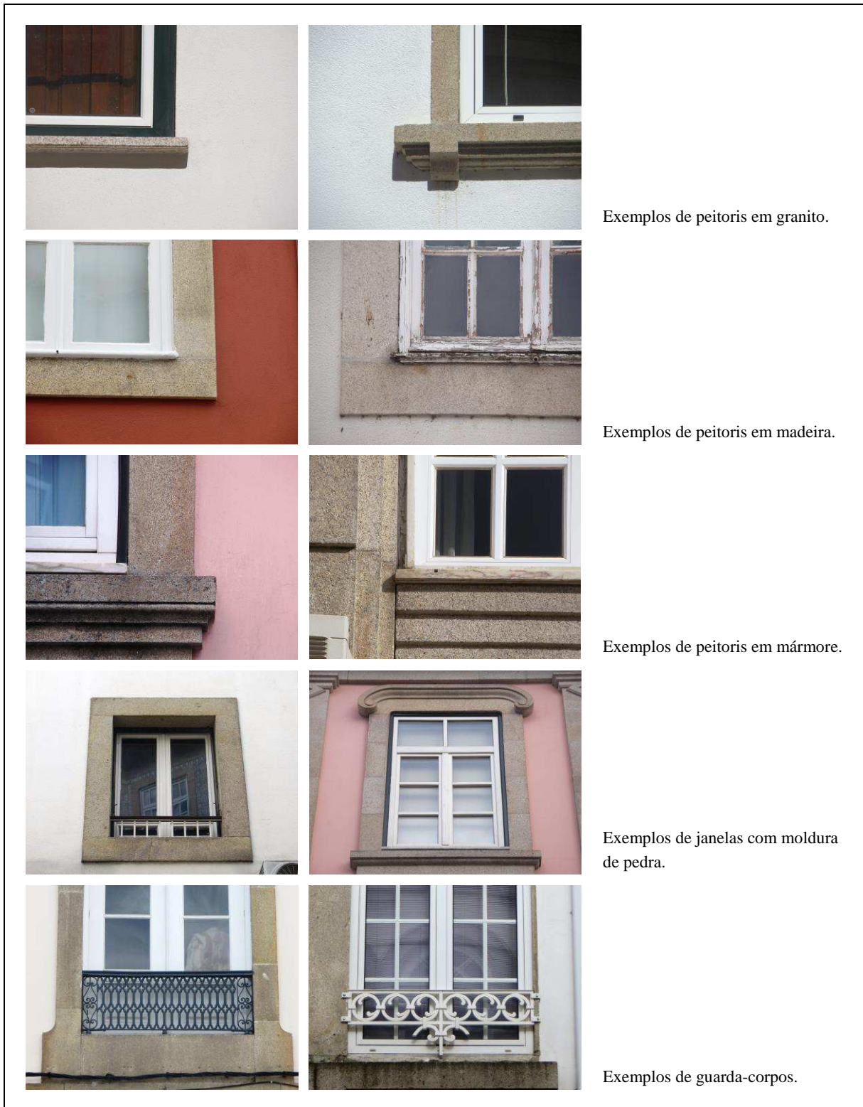
Figura 3.16 – Exemplos ilustrativos de materiais de peitoris e elementos acessórios a janelas (molduras e guarda-corpos)
