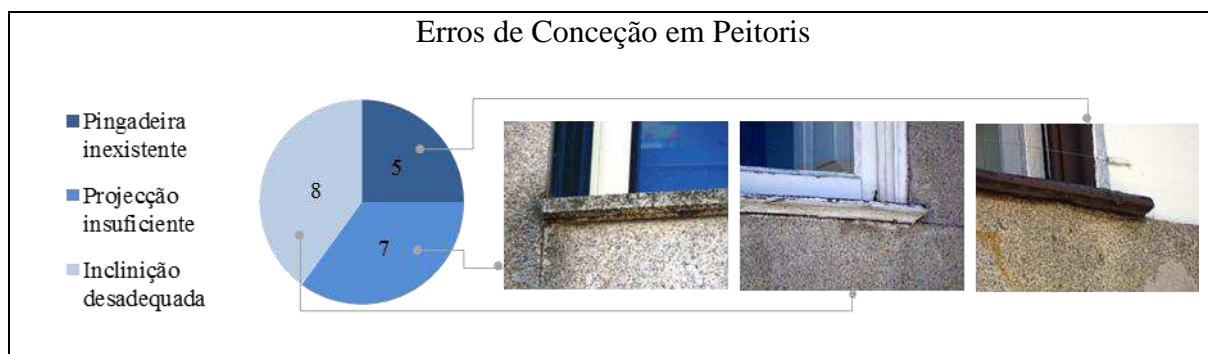
Figura 4.5 – Número de casos e exemplos ilustrativos de erros de conceção em peitoris
