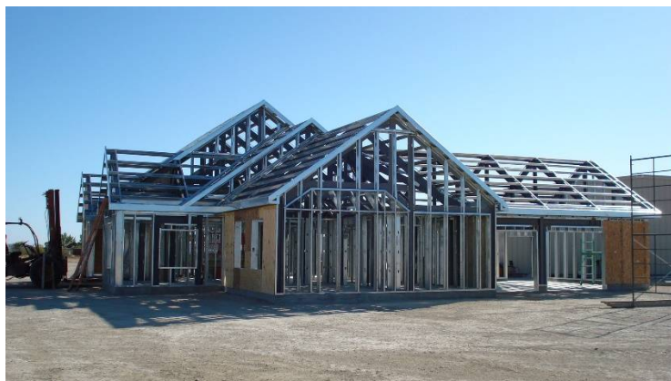
Figura 1.1 – Edifício de pequeno porte em aço enformado a frio (@steel-frame-homes)
