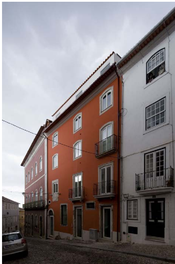
Figura 4 – Intervenções de investimentos privados
