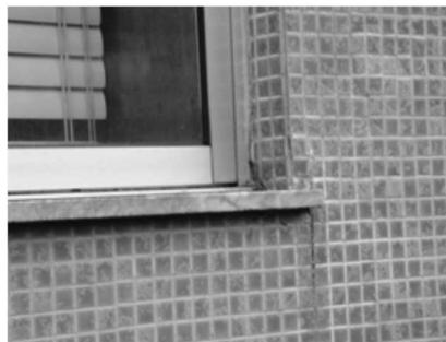
Falta de inclinação e perfil sem rasgo ou batente      Espessura reduzida ou mal apoiada risco fissuração
