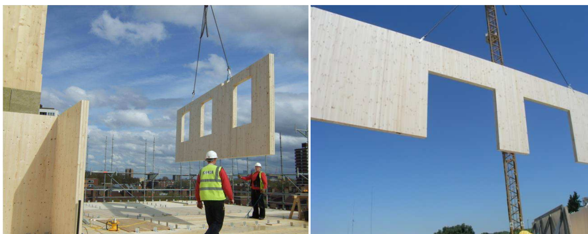
Figura 9- Aplicação em obra (Cedidas pela Tisem)
