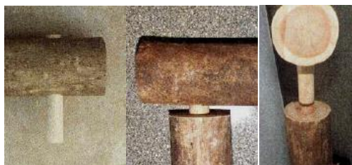
Figura 3.12 - Exemplos de ligações com cavilha de madeira (Calil et al 2003)
