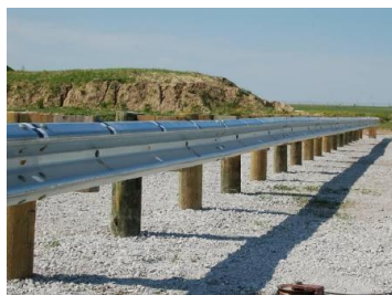
Figura 3.2 - Exemplo de aplicação da rolaria de madeira a rails de proteção (Morgado 2012)
