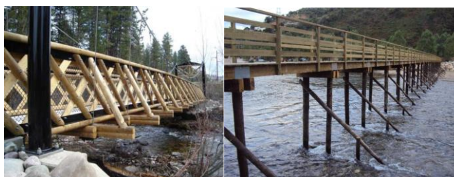
Figura 3.10 - Exemplos de pontes em madeira de rolaria (Morgado 2012)
