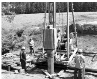
Figura 3.4 - Cravamento de uma estaca de madeira (Miná, 2005)
