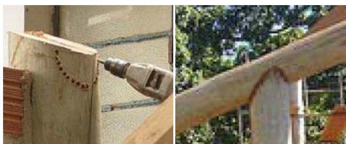
Figura 3.11 - Exemplos de ligações madeira – madeira (Calil et al 2003)
