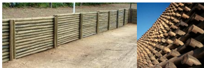
Figura 3.9 - Estabilização de taludes (Verde, 2010; Flach e Frenette, 2000)
