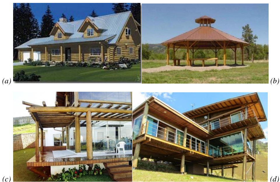
Figura 3.5 - a) Edifício (Ranta-Maunus, 1999) b) Edifício (Beaudette Consulting Engineers Inc, 2001) c) www.sampac.com.br d) ateliernobody.tumblr.com
