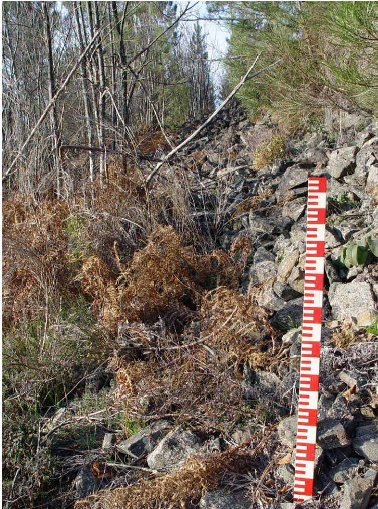
4 – Derrube de muralha
