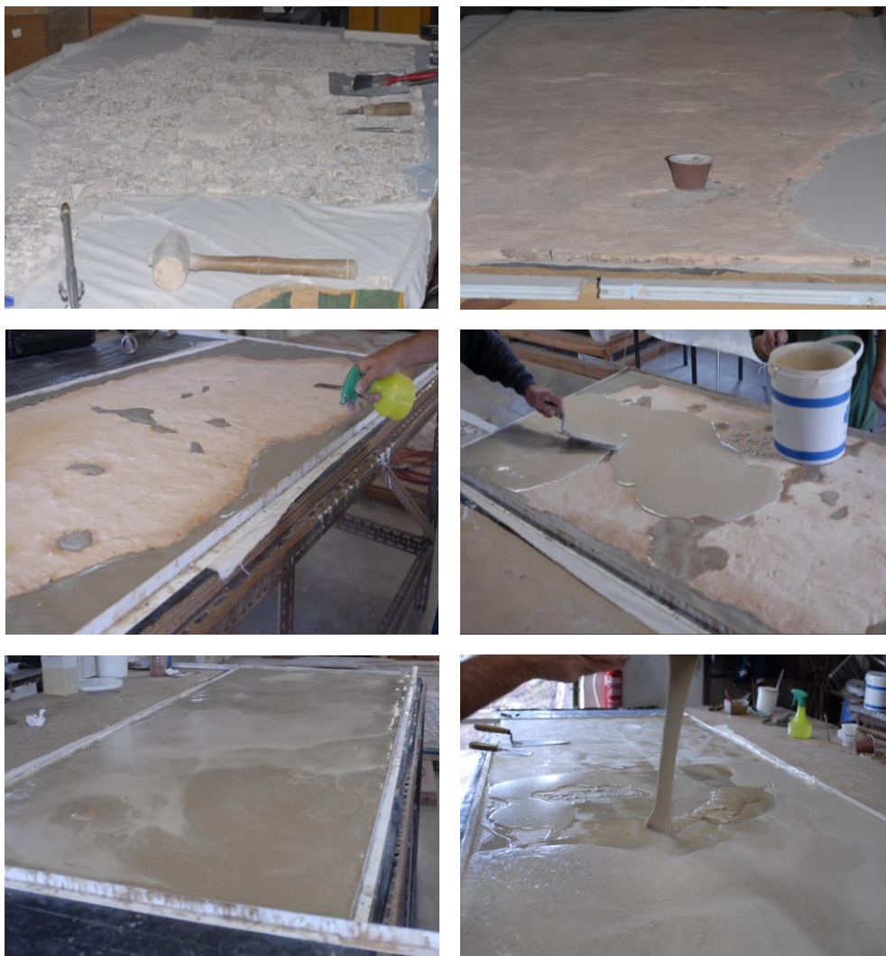
Figura A1: Processo de colocação do novo suporte (Fonte: MMC)
