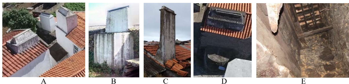
Figura 52 - Exemplos ilustrativos de saída de fumos (Chaminés – A e D; Fornos – B e D, e Fumeiro - E)
