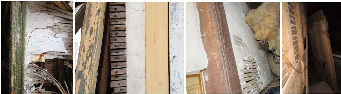
Figura 45 - Exemplos ilustrativos de paredes interiores do piso superior, em tabique
