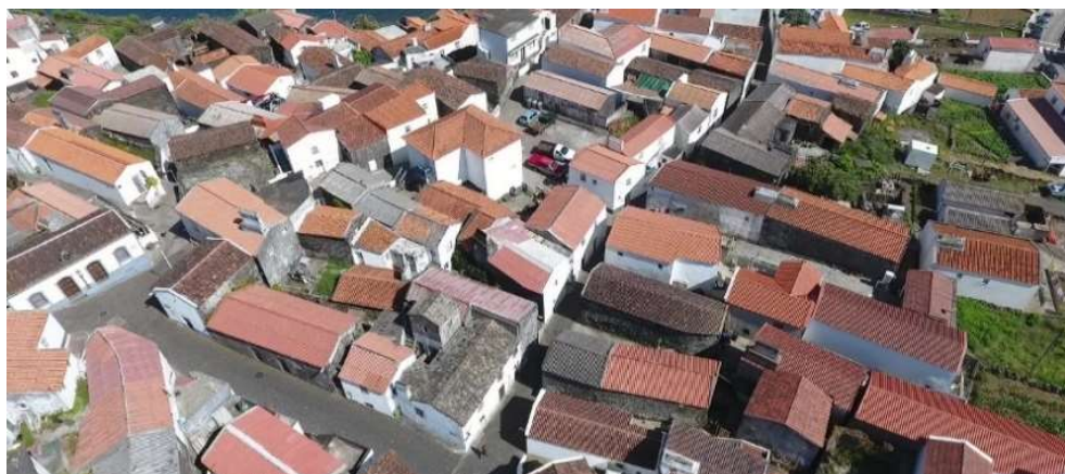
Figura 29 - Exemplo ilustrativo das coberturas do edificado do NAVC, correspondendo à zona assinalada na Figura 27 (fonte: Luís Pimentel)
