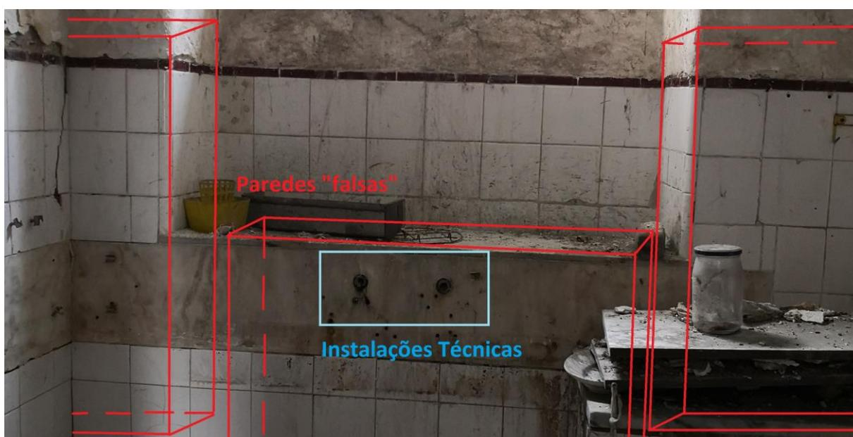
Figura 3.12 – Representação das paredes falsas e instalações técnicas da cozinha
