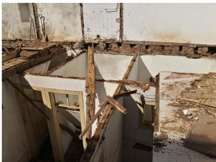
Figura 3.38 – Desmonte integral do interior de edifício (que não é o edifício em estudo)
