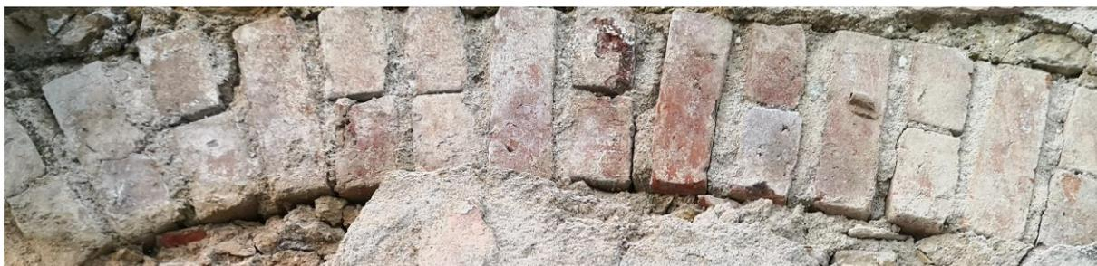
Figura 3.49 – Arco em tijolo maciço sobre janela (vista pelo exterior) ao nível do piso 0
