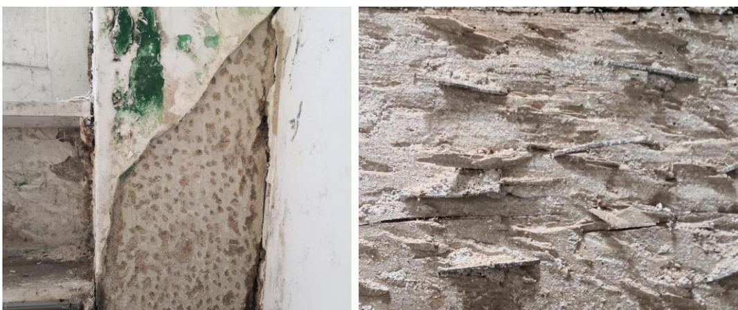
Figura 3.74 – Picagem e pregos para melhorar a aderência em camada intermédia de revestimento
