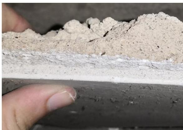
Figura 3.73 – Camadas do revestimento interior em paredes exteriores e interiores de frontal
