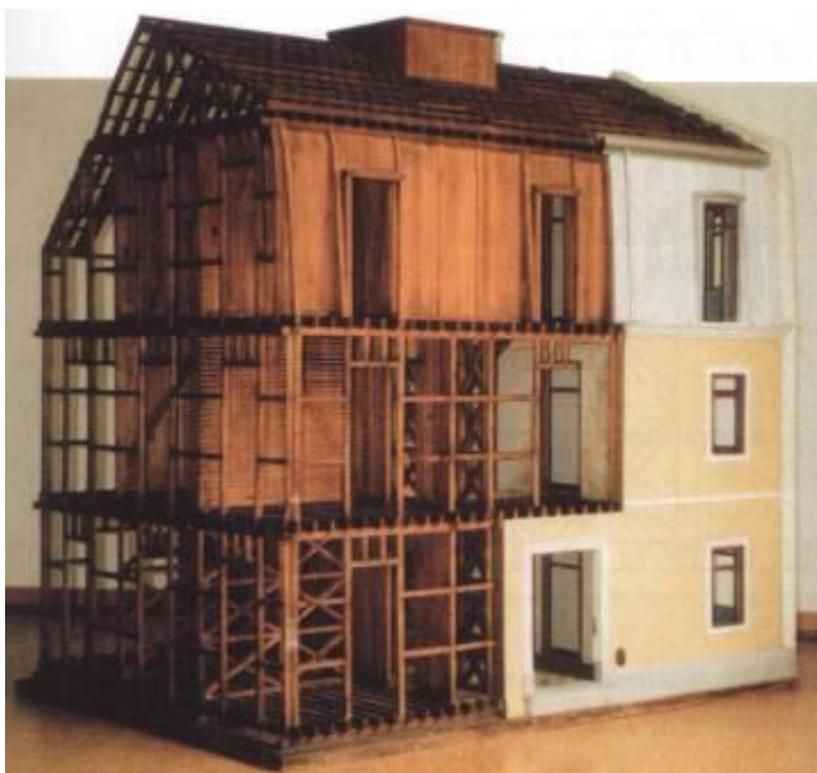
Figura 2.15 – Modelo estrutural da Gaiola Pombalina (*Website* do LNEC)
