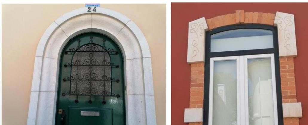
Figura 2.36 – Abertura com arco em pedra (esq.) e tijolo maciço (dir.)
