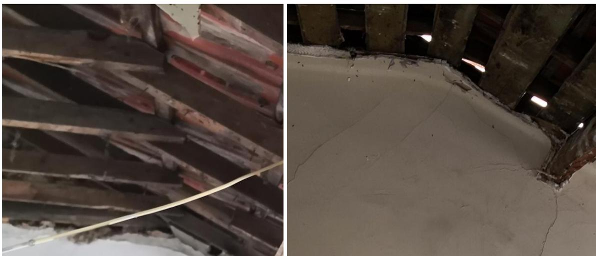
Figura 3.70 – Nivelamento do teto no piso superior: barrotes de suporte (esq.) e pranchas remanescentes após desmonte (dir.)
