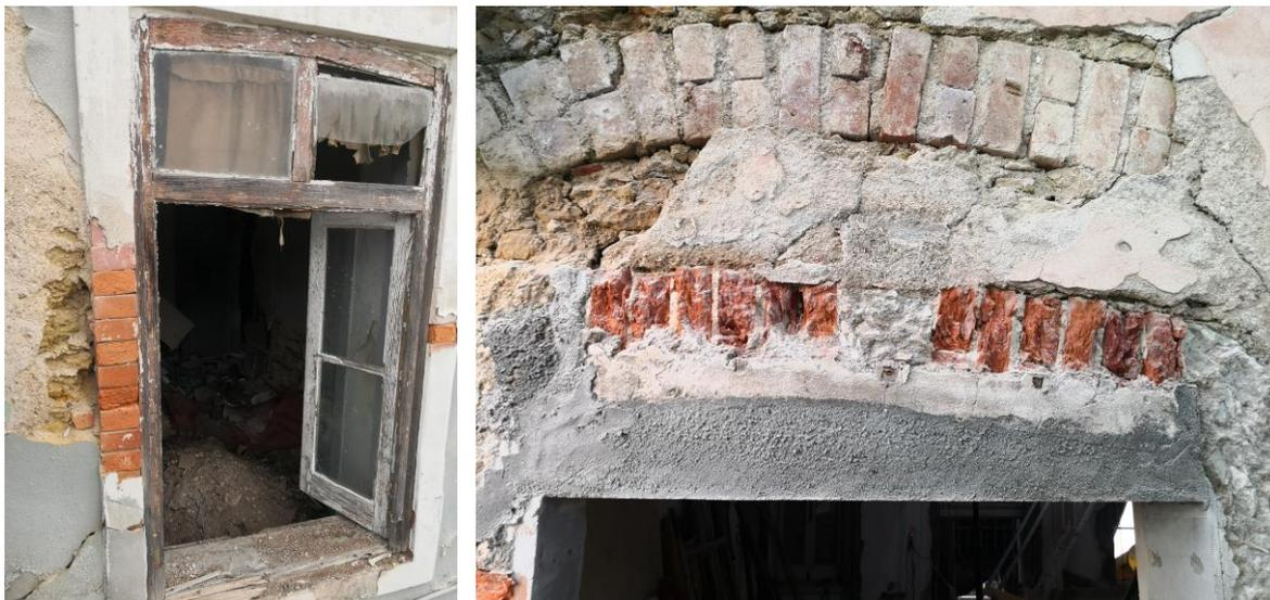
Figura 3.78 – Contorno em tijolo maciço (à esq.), arco e verga em tijolo maciço (à dir.)
