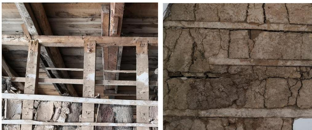
Figura 3.56 – Frontal pregado a frechal no topo e sobreposição de vigas de piso (esq.); núcleos de terra entre ripas (dir.)
