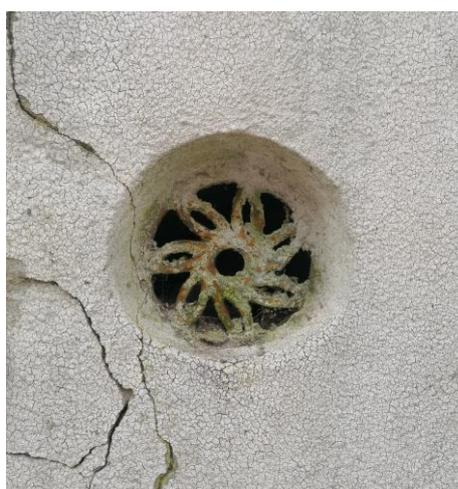
Figura 3.15 – Grelha de ventilação no alçado principal
