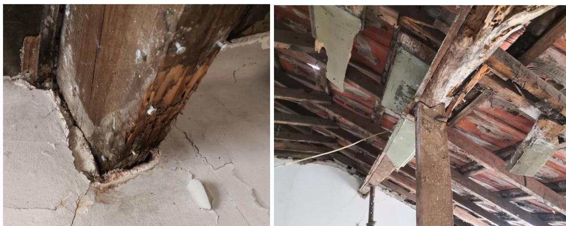
Figura 3.68 – Viga madre: apoio na empena (esq.); apoio intermédio criado por prumo (dir.)
