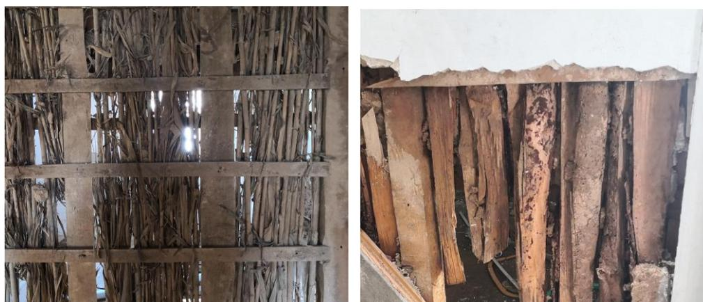
Figura 3.58 – Frontal preenchido com cana de milho (esq.) e cavacas de madeira (dir.)
