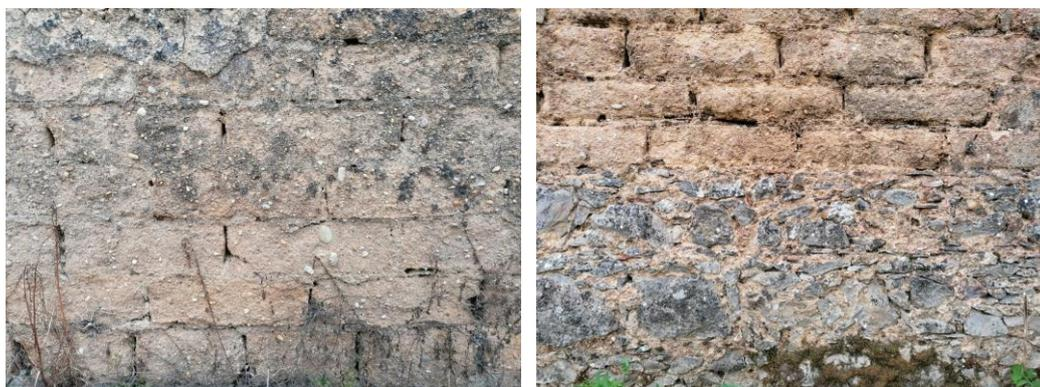
Figura 2.8 – Blocos de adobe (esq.), construção em adobe sobre alvenaria de pedra (dir.)
