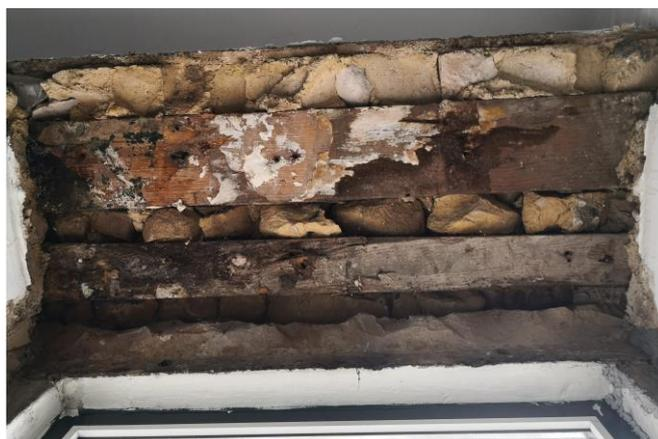
Figura 3.44 – Suporte do enchimento entre a janela e arco
