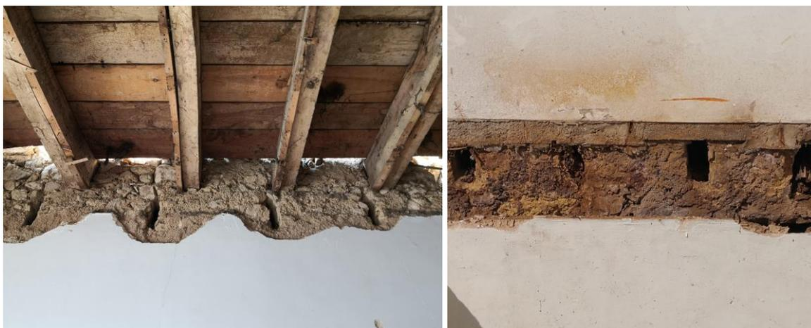
Figura 3.62 – Ligação das vigas de pavimento a parede exterior
