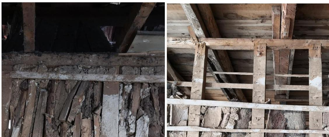
Figura 3.63 – Vigas apoiadas nas paredes interiores de frontal
