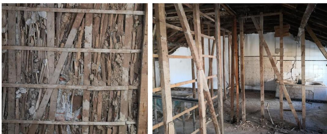
Figura 3.57 – Escoras diagonais em parede de frontal
