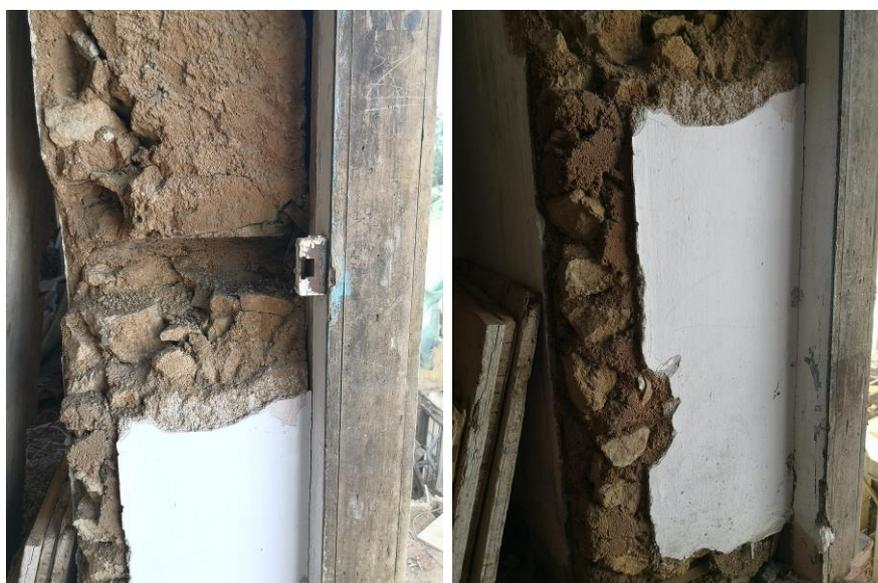
Figura 3.42 – Ombreira de porta constituindo um “corte” da parede
