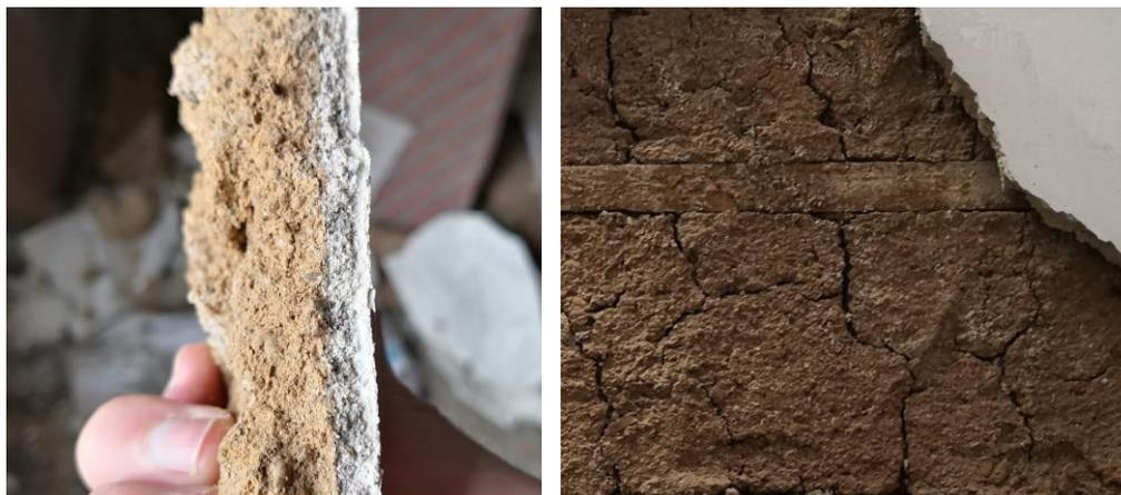
Figura 3.76 – Revestimento das paredes de frontal com emboço em terra barrenta
