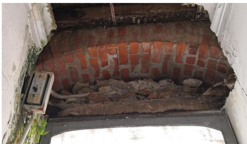
Figura 3.50 – Arco e tijolo maciço sobre porta de entrada (vista pelo interior)
