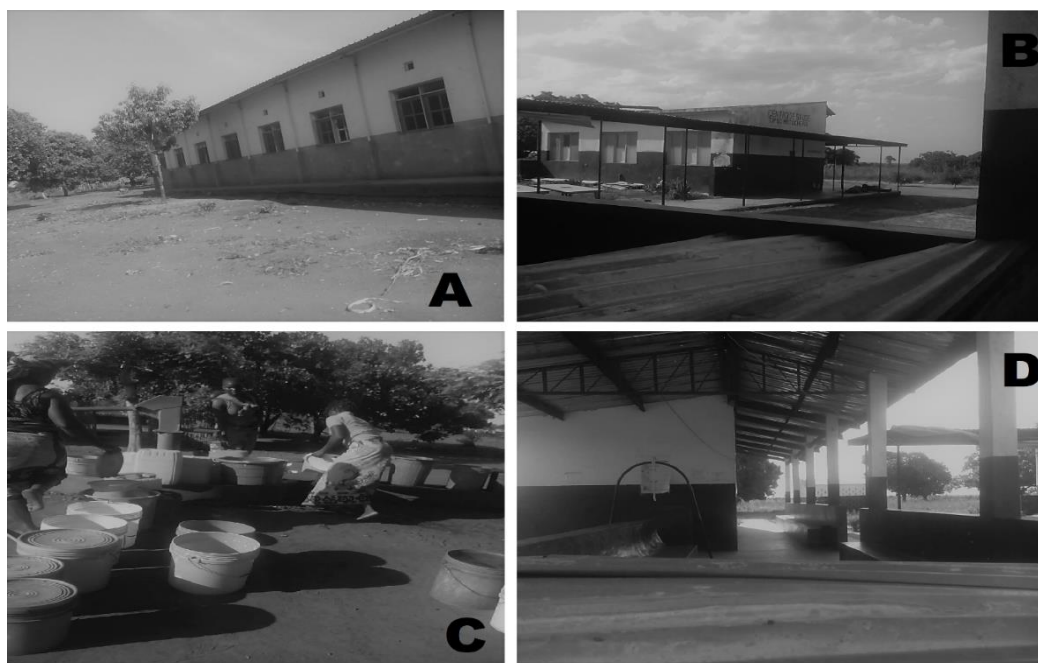
Imagem 5 - Infraestruturas construídas pela empresa MML na comunidade de Metocheria Agrícola
