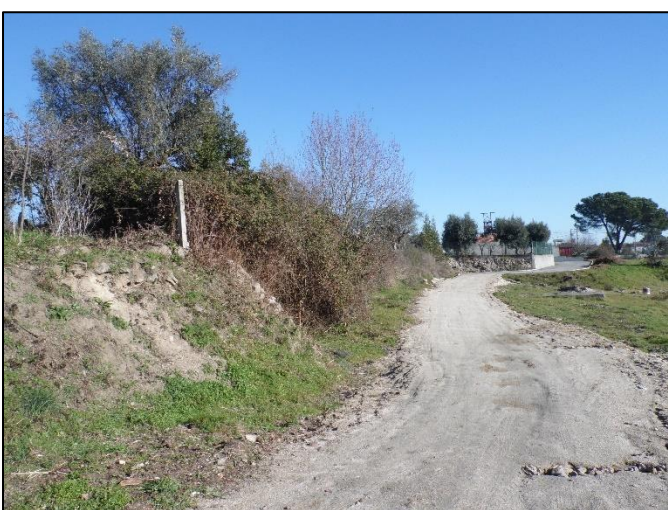
5.B) Vista este do corte do talude no Freixeiro.
