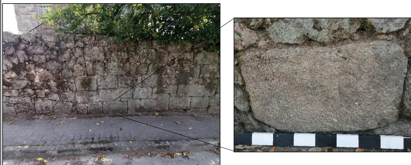
19.A) Pormenor do aparelho construtivo e localização do bloco granítico com marca de canteira.
