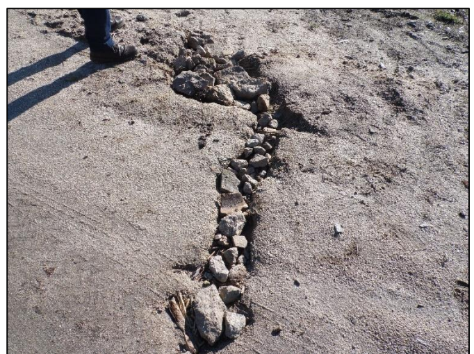
5.C) Pormenor da reutilização local de materiais cerâmicos de construção.
