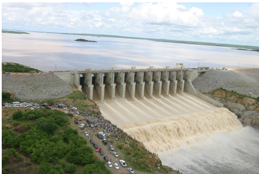
Figura 2.1 – Barragem do Castanhão (centralquixadá.blogpost.com, 2019)
