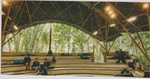
> ESTRUTURA ESPACIAL DE BAMBU PARA ANFITEATRO AO AR LIVRE / BAMBUTECH DESIGN
