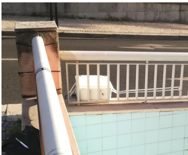
Figura C.1 – Local de instalação do equipamento de medição GRIMM.
