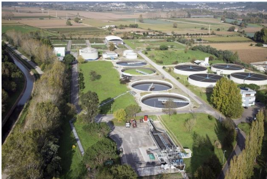
Figura 2.2 - ETAR do Choupal, Coimbra (imagem do site das Águas do Centro Litoral - http://www.aguasdocentrolitoral.pt/ ).
