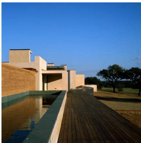
Fig. 12.20 – Casa em Taipa, 5 de fevereiro de 2008. Autora: Catarina Costa Cabral. Fonte: Arquivo Bartolomeu Costa Cabral
