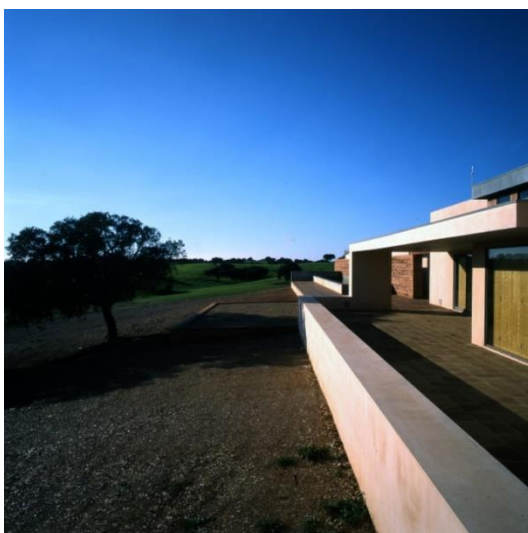
Fig. 12.19 – Casa em Taipa, 5 de fevereiro de 2008. Autora: Catarina Costa Cabral. Fonte: Arquivo Bartolomeu Costa Cabral
