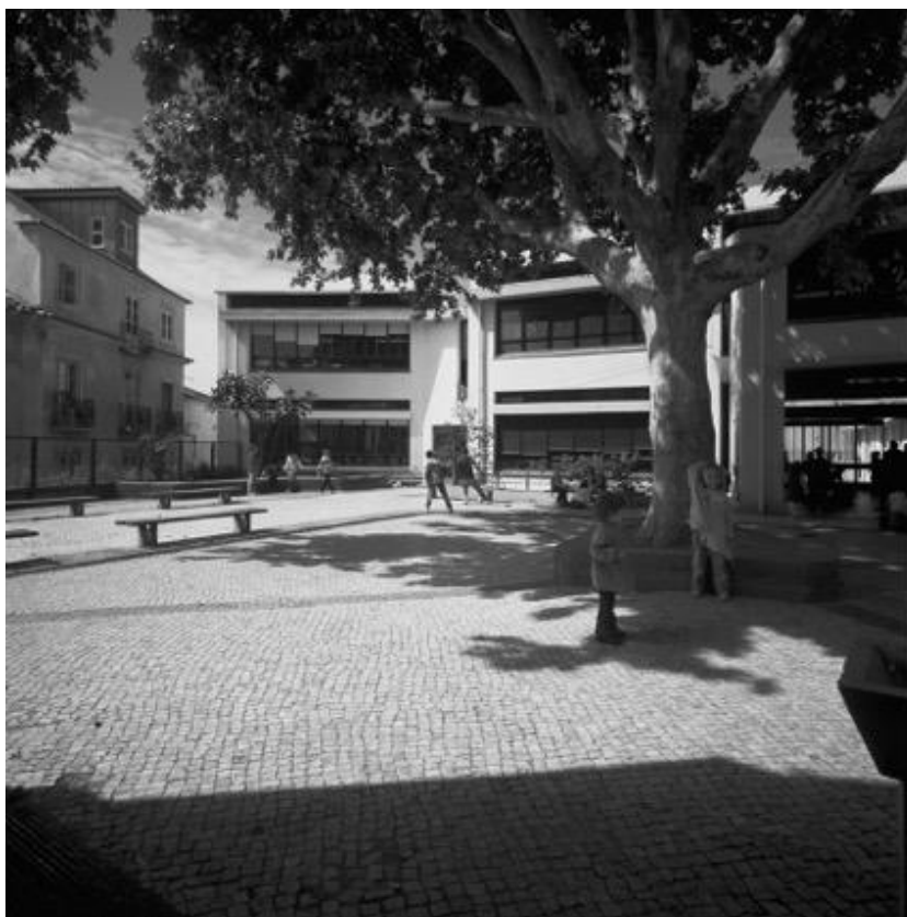
Fig. 7.29 – Pátio principal, Grupo Escolar e Balneário do Castelo, s.d.. Fonte: Arquivo Bartolomeu Costa Cabral
