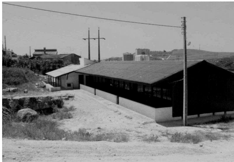
Fig. 11.28 – Escola no Bairro do Pego Longo (demolida). s.d. Fonte: Arquivo Bartolomeu Costa Cabral
