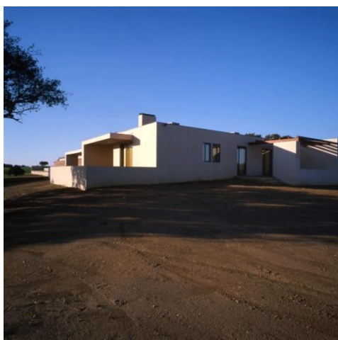
Fig. 12.23 – Casa em Taipa, 5 de fevereiro de 2008. Autora: Catarina Costa Cabral. Fonte: Arquivo Bartolomeu Costa Cabral
