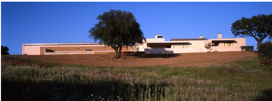
Fig. 12.18 – Casa em Taipa, alçado sudoeste, 5 de fevereiro de 2008. Autora: Catarina Costa Cabral. Fonte: Arquivo Bartolomeu Costa Cabral
