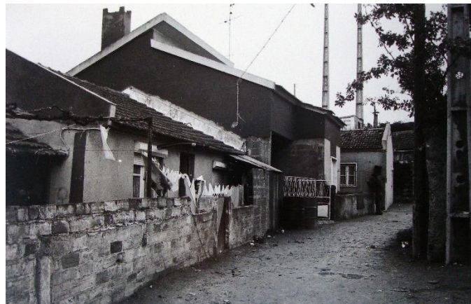
Fig. 11.4 – Bairro do Pego Longo antes da intervenção de Bartolomeu Costa Cabral, mostrando já uma habitação (autoconstruída) em alvenaria de tijolo, s.d. [1976?] Autor: Bartolomeu Costa Cabral. Fonte: Arquivo Bartolomeu Costa Cabral
