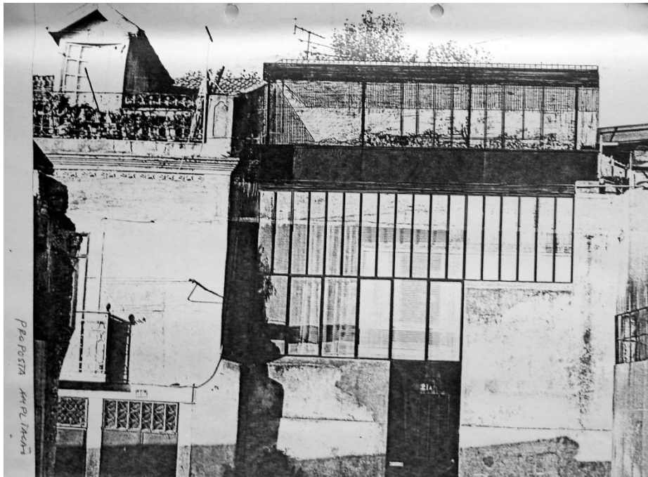
Fig. 9.20 – Fotomontagem da Proposta de Ampliação da Casa na Rua da Verónica, s.d. [março de 1984]. Arquivo Bartolomeu Costa Cabral
