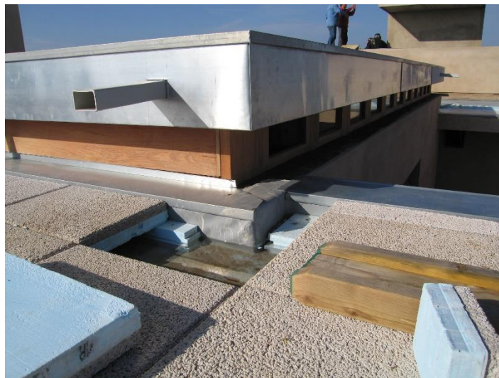
Fig. 12.17 – Construção da Casa em Taipa, 28 de dezembro de 2006. Fonte: Arquivo Bartolomeu Costa Cabral
