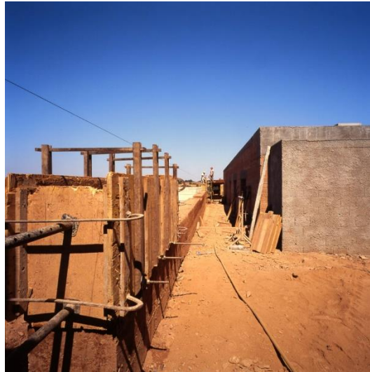
Fig. 12.16 – Construção da Casa em Taipa, s.d. Fonte: Arquivo Bartolomeu Costa Cabral
