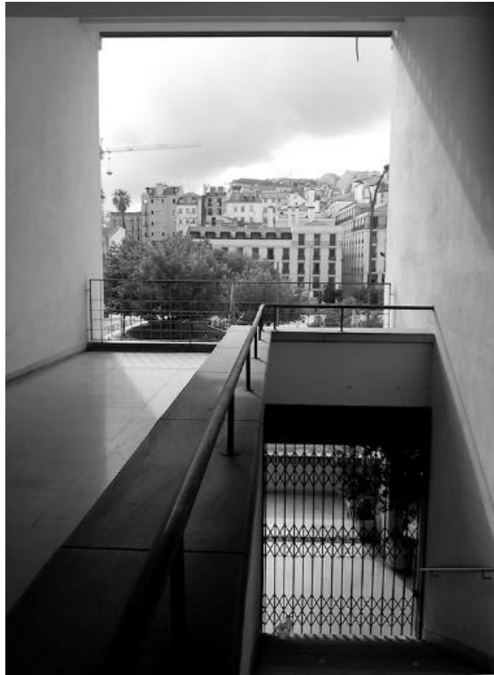
Fig. 10.59 – Miradouro no corpo C (piso 2) com vista para a Colina de Sant'Ana (vão planeado para a construção da passagem aérea), maio de 2016. Autora: Mariana Couto
