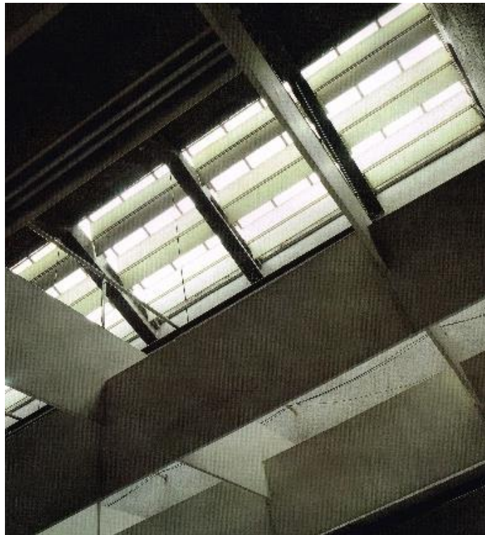
Fig. 8.18 – Vista do teto de sala de aula no piso superior do edifício da Primeira Fase (Pilão) do Instituto Politécnico da Covilhã, s.d. Autora: Catarina Costa Cabral. Fonte: Arquivo Bartolomeu Costa Cabral
