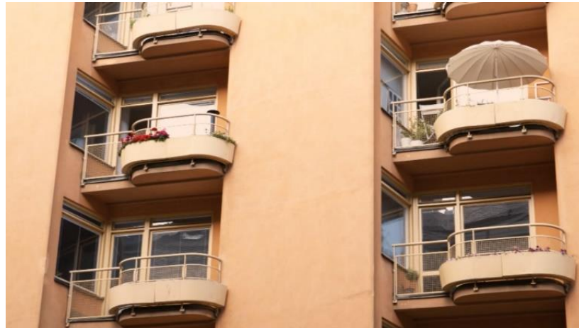
Fig. 4.12 – Varandas do edifício de habitação coletiva em Estocolmo (Kollektivhuset, John Ericssonsgatan 6, 1930-1935), de Sven Markelius, Fonte: https://vimeo.com/152390258
