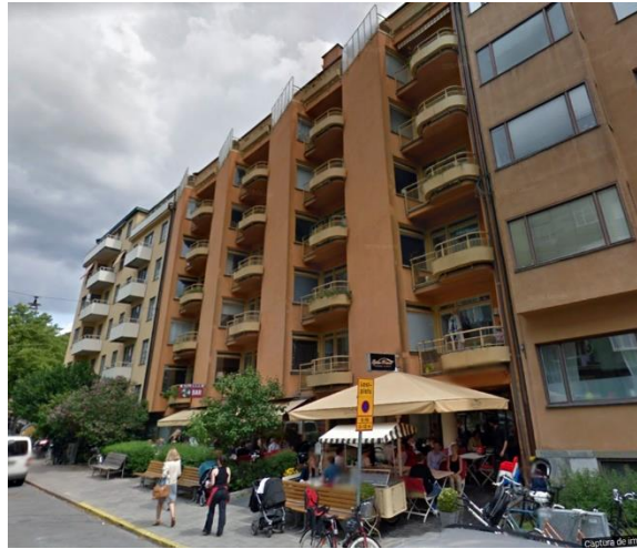
Fig. 4.11 – Fachada principal do edifício de habitação coletiva em Estocolmo (Kollektivhuset, John Ericssonsgatan , 1930-1935) de Sven Markelius, Fonte: Google Maps (2019)
