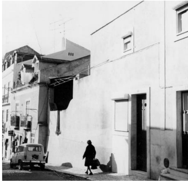
Fig. 9.4 – Fotografia do armazém na Rua da Verónica antes da intervenção de Bartolomeu Costa Cabral, s.d. [1973?]. Autor: Bartolomeu Costa Cabral. Fonte: Arquivo Bartolomeu Costa Cabral
