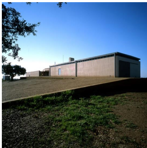
Fig. 12.22 – Casa em Taipa, 5 de fevereiro de 2008. Autora: Catarina Costa Cabral. Fonte: Arquivo Bartolomeu Costa Cabral
