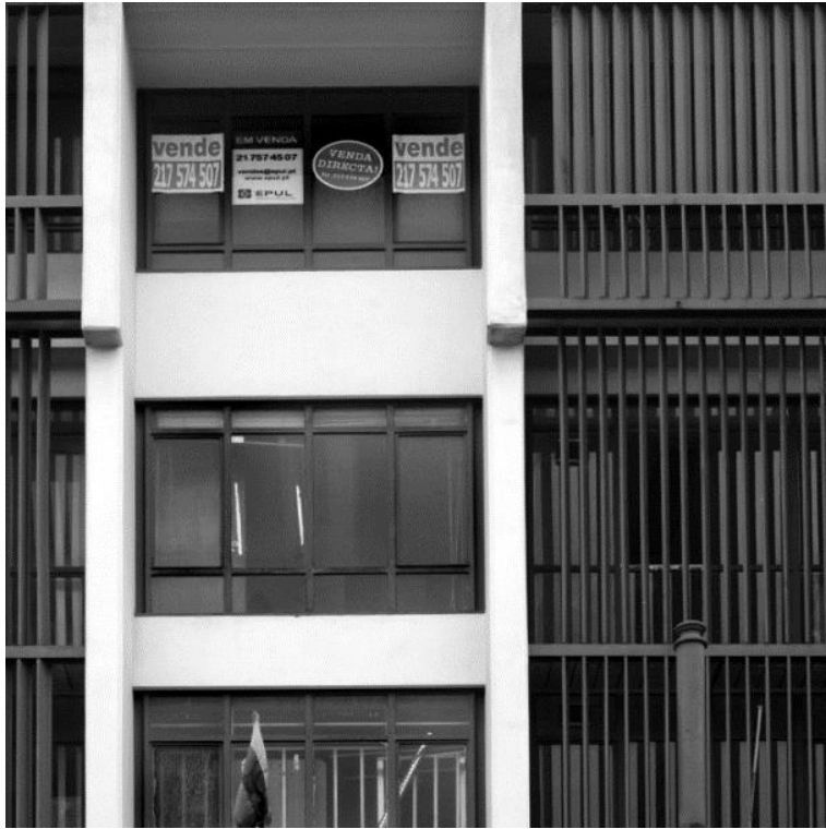
Fig. 10.57 – Fotografia de parte da fachada principal do corpo C. s.d. Autora: Catarina Costa Cabral. Fonte: Arquivo Bartolomeu Costa Cabral
