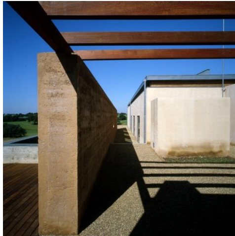
Fig. 12.28 – Casa em Taipa, vista da piscina, dos ateliers e do corredor exterior a partir do pátio de serviço, 5 de fevereiro de 2008. Autora: Catarina Costa Cabral. Fonte: Arquivo Bartolomeu Costa Cabral
