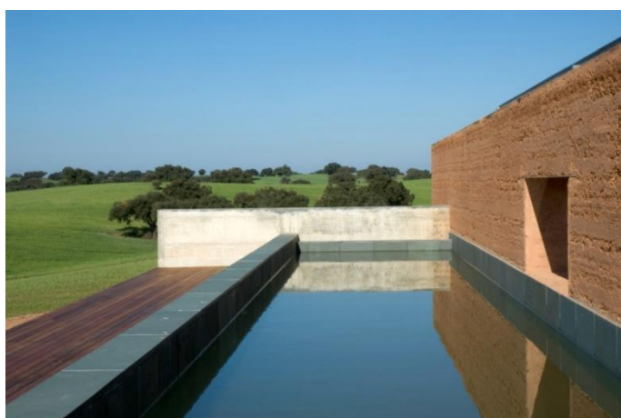
Fig. 12.21 – Casa em Taipa, 5 de fevereiro de 2008. Autora: Catarina Costa Cabral. Fonte: Arquivo Bartolomeu Costa Cabral
