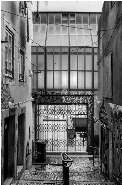
Fig. 10.58 – Corpo C visto a partir do Beco do Cascalho; envidraçado a nascente e atravessamento atualmente encerrado, s.d. Autora: Catarina Costa Cabral. Fonte: Arquivo Bartolomeu Costa Cabral
