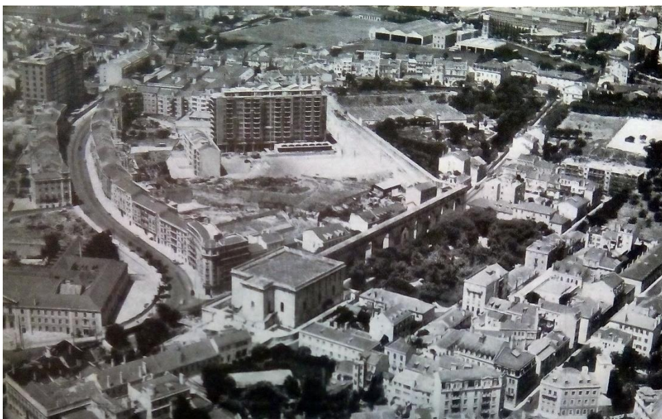
Fig. 4.1 – Fotografia Aérea do Bloco das Águas Livres publicadas na revista Arquitectura em 1959. Fonte: Arquitectura. Lisboa. 3ª série, N.º 65 (junho de 1959), p.3
