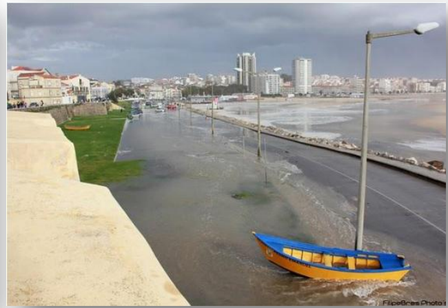
Figura 37 – Efeito de galgamento costeiro no Forte de Buarcos. Fonte: Fotografia de Filipe Brás, 9 de outubro de 2010, in H. F. Almeida, 2019, p.120.
