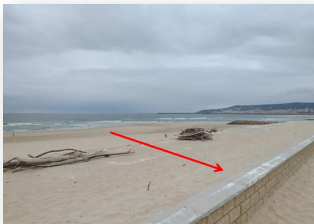
Figura 30 – Observação da extensão do areal na praia da Cova; → extensão de enrocamento (aprox. 4 m de largura) colocada em áreas onde a duna desapareceu, procurando mitigar o efeito erosivo da ondulação, particularmente no período entre o outono-primavera. Fonte: acervo pessoal, 6 de junho de 2020.
