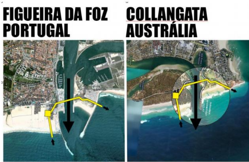
Figura 40 – Esquema da possível implementação do Bypass na Figueira da Foz. Fonte: H. F. Almeida, 2019, p.89.
