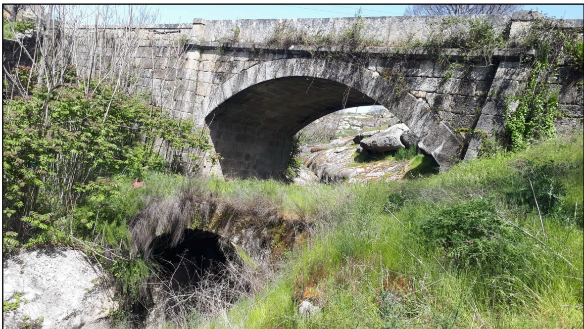
Figura 5 – Sobreposição de pontes: Ponte do Moinho do Buraco.
