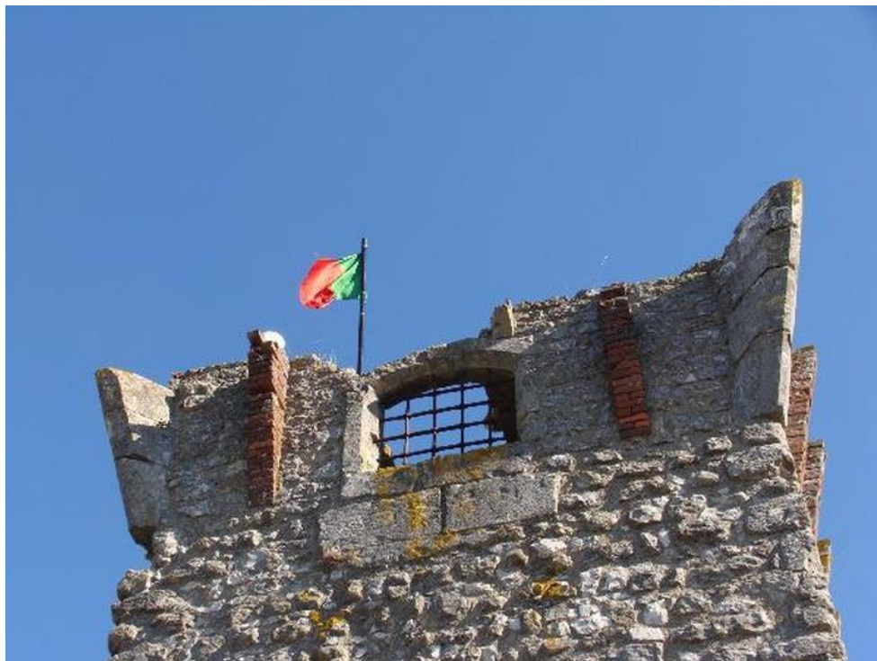
Figura A2.4. – Pormenor das mísulas da Torre D. Mécia. Fonte: DGPC.
