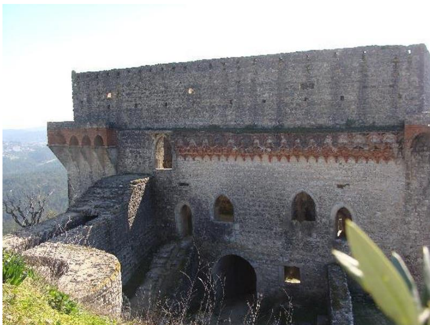
Figura A2.8. – Fachada Norte do Paço dos Condes. Fonte: DGPC.
