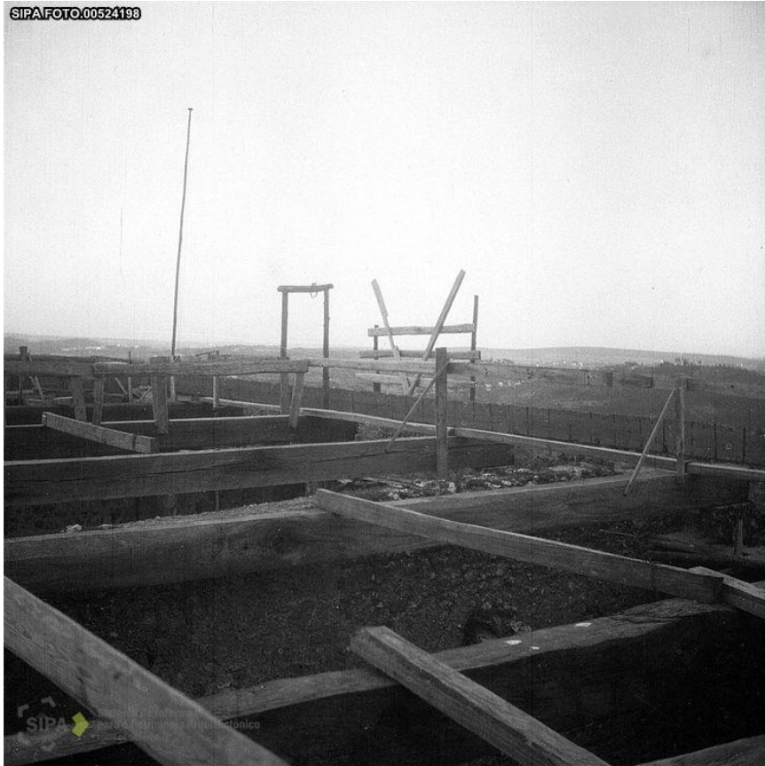
Figura A2.17. – Aplicação de estrutura para cobertura no Paço. Fonte: SIPA.
