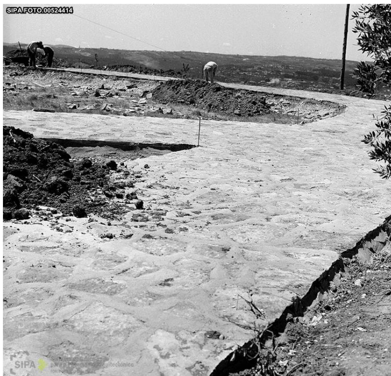
Figura A2.18. – Aplicação de pavimento no Terreiro de São Tiago, 1985. Fonte: SIPA.
