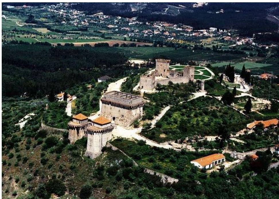
Figura A2.1. – Vista aérea do Complexo Monumental, constituído por Castelo com planta triangular (com três torres), Paço dos Condes (planta retangular) e dois torreões defensivos. 1993. Fonte: SIPA.
