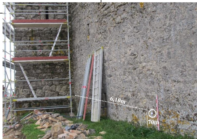
Fig. 13.2 – Localização da amostra n° 11 da muralha exterior do Castelo.
