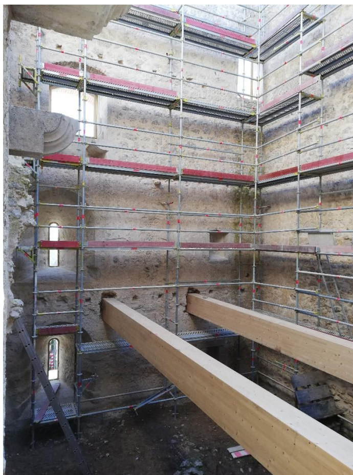
Figura A3.2. – Futura sala polivalente. Interior do Paço dos Condes no decorrer das intervenções para Espaço Museológico. Março 2020 ( Fotografia do autor ).
