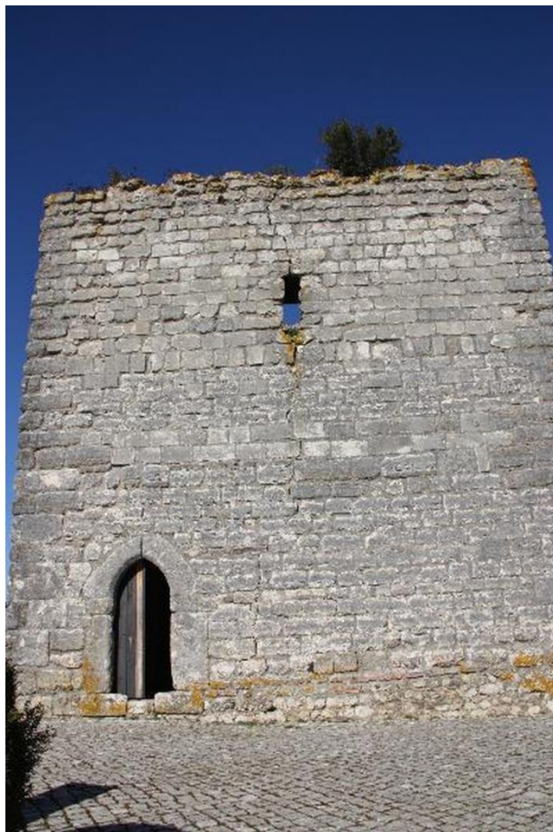
Figura A2.6. – Alçado Exterior Sul da Torre do Alcaide. Porta de entrada em arco quebrado. Fonte: DGPC.
