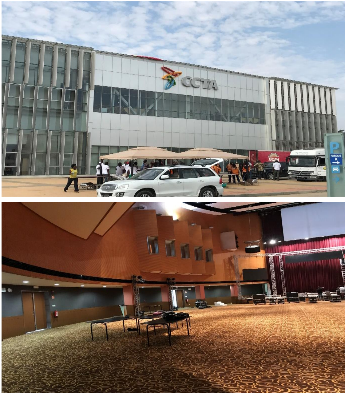
Figura III.18. Centro de Convenções Talatona, localizado em Luanda Sul, inaugurado em 2006. Em cima perspectiva exterior, em baixo imagem do auditório. Fotografia de Fernando Paulo Maria, 2019.
