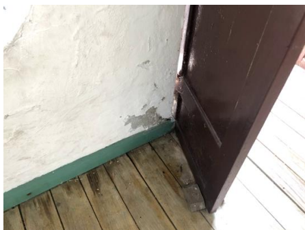
Figura 29: Solar da Beira Alta - Sujidade, destacamento e empolamento do revestimento devido a humidade. (Fonte: Autor, 2019)
