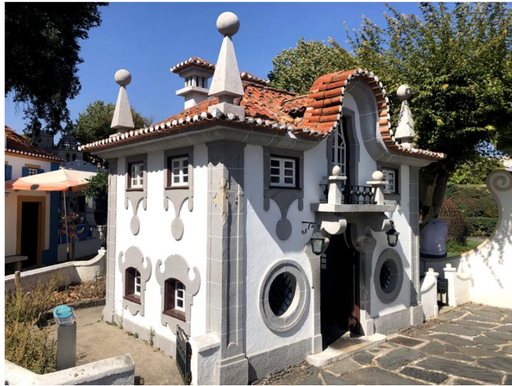
Figura 54: Fotografia do Solar da Beira Alta. (Fonte: Autor, 2019)
