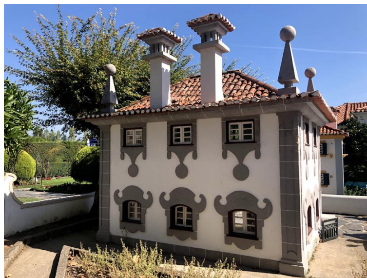
Figura 55: Fotografia do Solar da Beira Alta. (Fonte: Autor, 2019)
