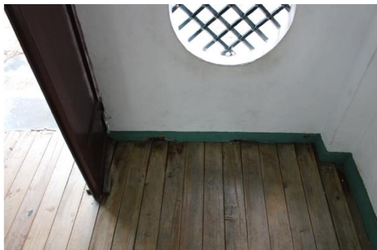
Figura 45: Solar da Beira Alta - Presença de manchas de humidade no pavimento de madeira com ataque biológico no rodapé e empolamentos devido à absorção de humidade. (Fonte: Autor, 2019)
